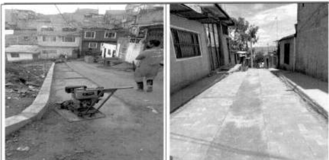
Instalacion adoquin por la comunidad
