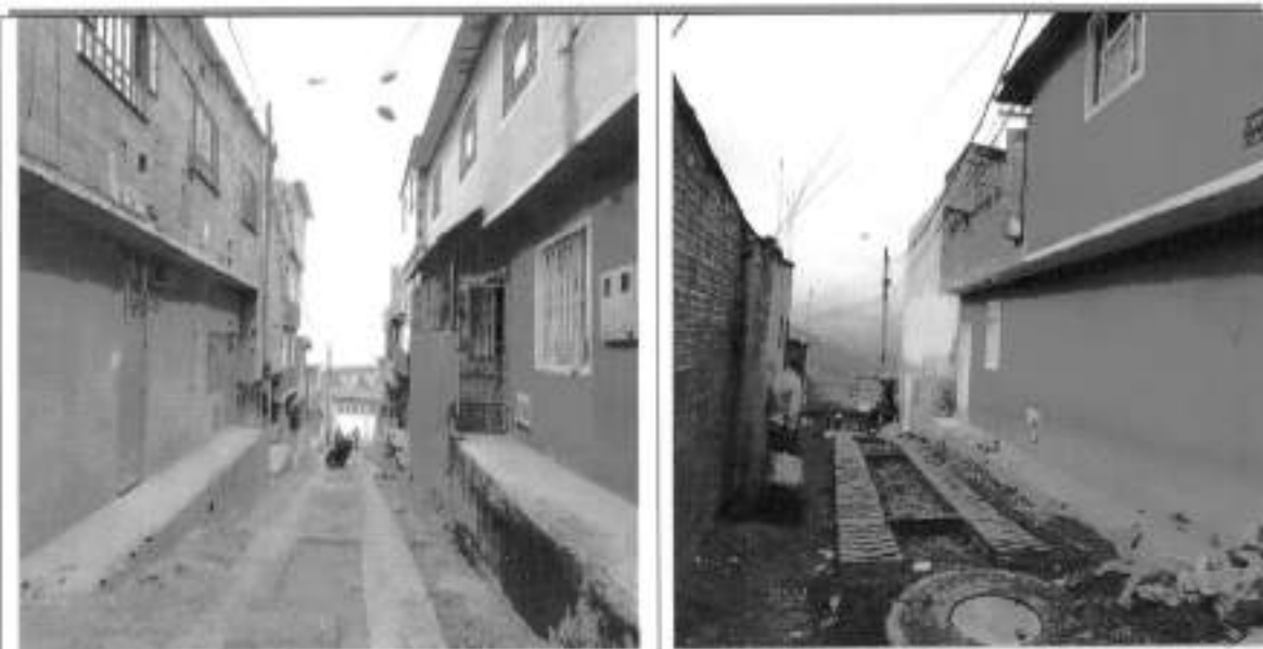
FUNDIDA CINTAS EN CONCRETO CRA 25B ESTE CLL 59 y Cra 27 este cl 53
