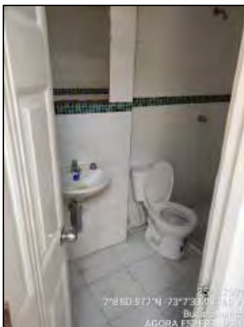
Ilustración 11. Baño, lavamanos y punto de hidratación.
