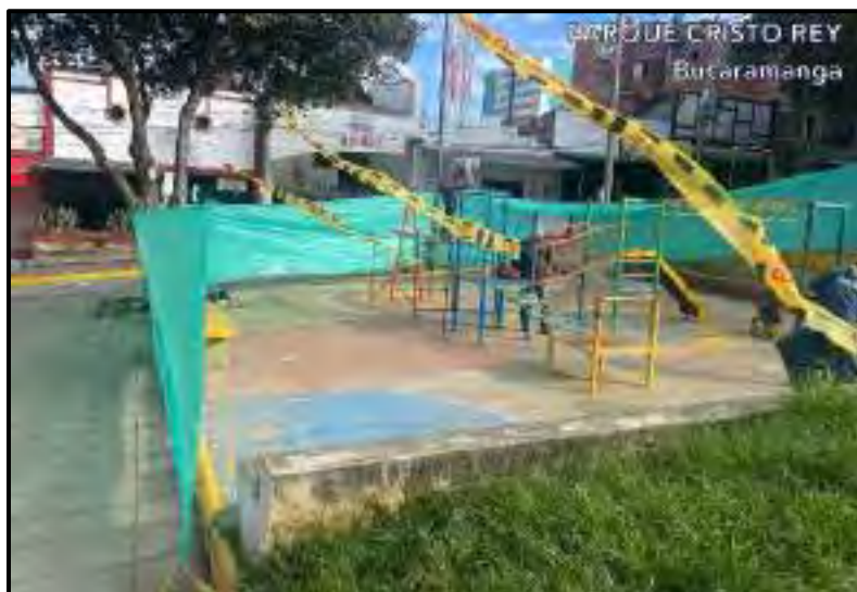
Ilustración 12. Cerramiento en lona
