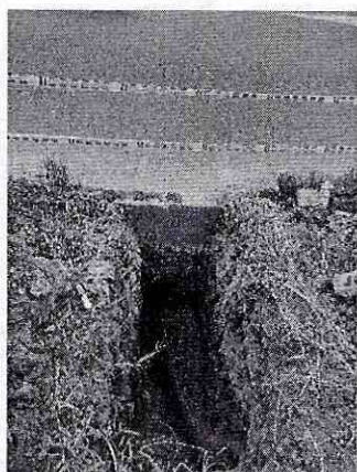
Canalización de tubería pvc 2" en calzada, excavación con compresor de bala teledirigida de 5" (topo)
