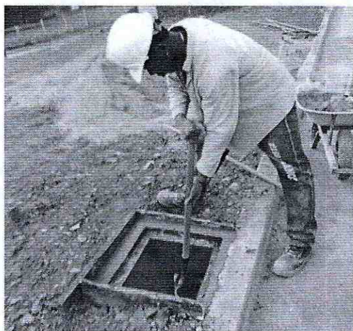
Instalación de Tubería PVC DB de 2"
