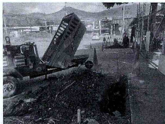
Canalizacion de tuberia pvc 2" en calzada, excavacion con compresor de bala teledirigida de 5" (topo)
