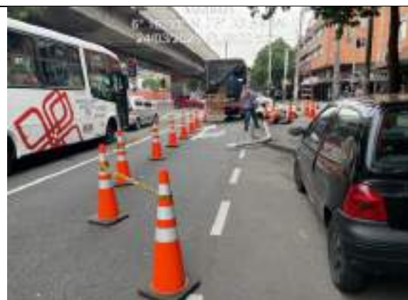
Fotografía 7: señalización de frentes de trabajo
