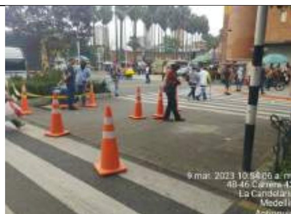
Fotografía 9: señalización de frentes de trabajo
