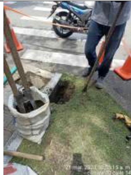
Fotografía 31: Construcción canalización en zona verde Carrera 70 con calle 14
