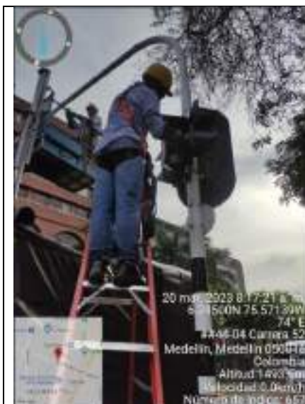
Fotografía 28: Lavada poste y brazo de ménsula. Carrera 52 con calle 44
