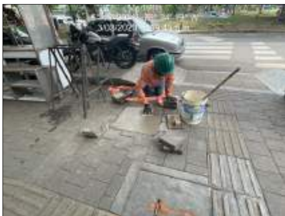
Fotografía 12: Uso de epp
