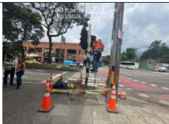
Fotografía 22: Trabajo en alturas
