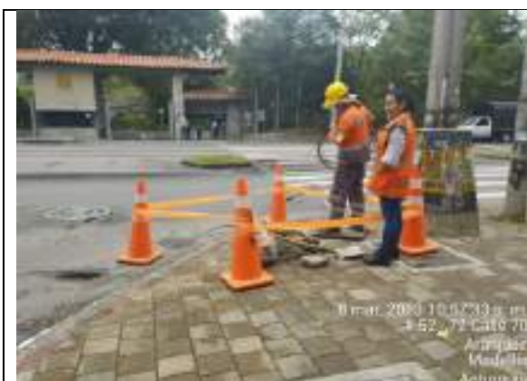
Fotografía 8: Delimitación frentes de trabajo
