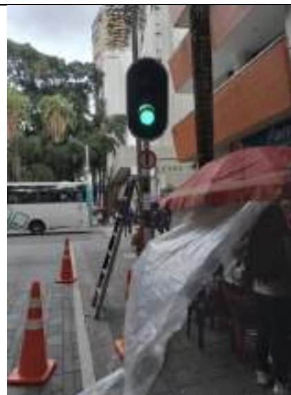
Fotografía 2: Instalación disco direccional. Carrera 41 con calle 55
