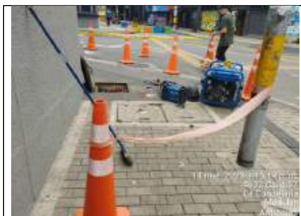
Fotografía 3: Estado de equipos dispuestos en obra
