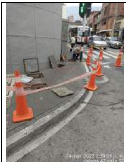
Fotografía 17: Instalación semáforo peatonal conteo regresivo. Carrera 47 con calle 57
