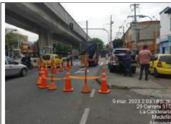
Fotografía 10: señalización de frentes de trabajo
