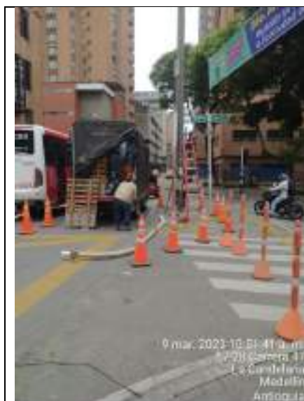
Fotografía 7: Instalación de ménsula. Carrera 47 con calle 57a
