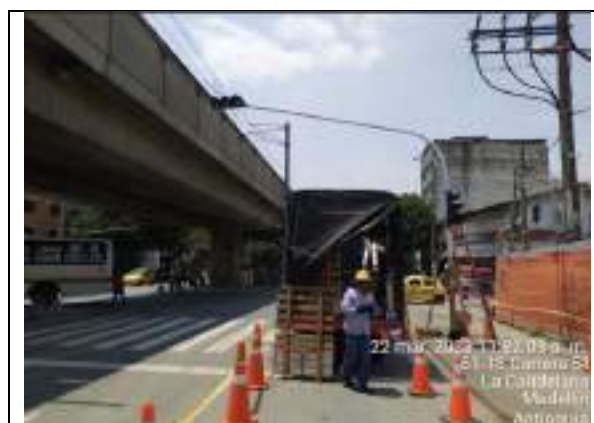
Fotografía 9: Instalación de ménsula. Carrera 51 con calle 62
