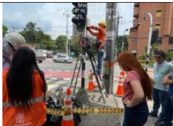
Fotografía 21: Trabajo en alturas
