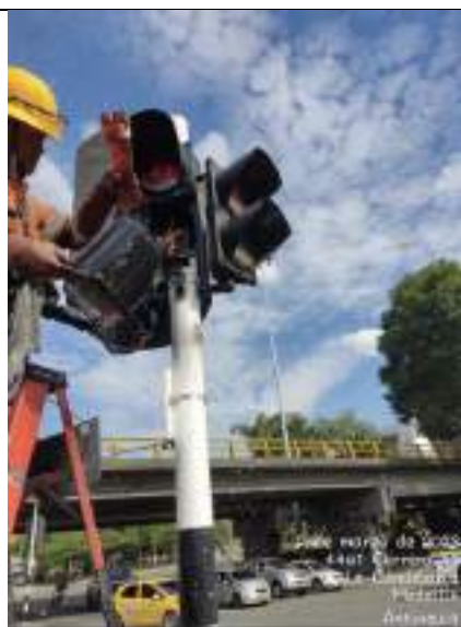
Fotografía 23: Lavada poste de semáforo vehicular Carrera 57 con calle 44
