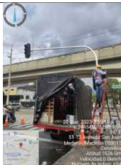
Fotografía 29: : Lavada poste y brazo de ménsula. Carrera 51 con calle 44
