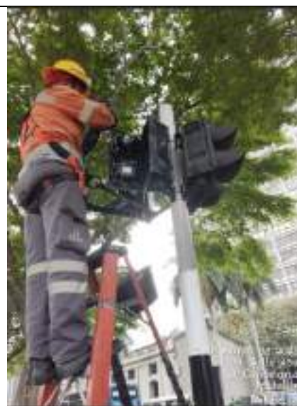
Fotografía 24: Lavada poste de semáforo. Parque de las luces
