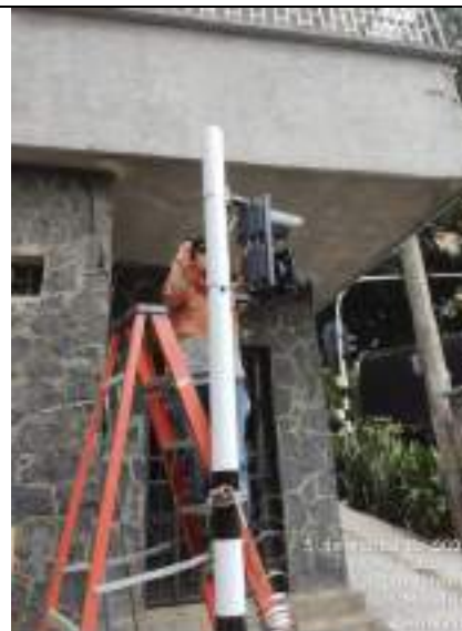
Fotografía 15: Instalación semáforo. Carrera 41 con calle 58
