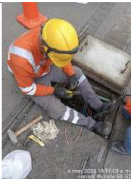
Fotografía 18: Instalación cable de control. Carrera 63C con calle 42
