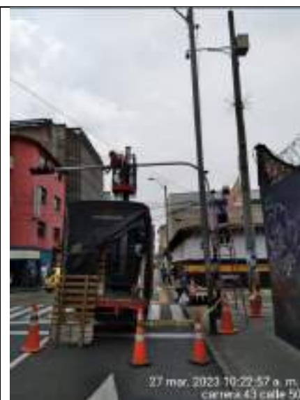
Fotografía 8: Instalación de ménsula. Carrera 43 con calle 50
