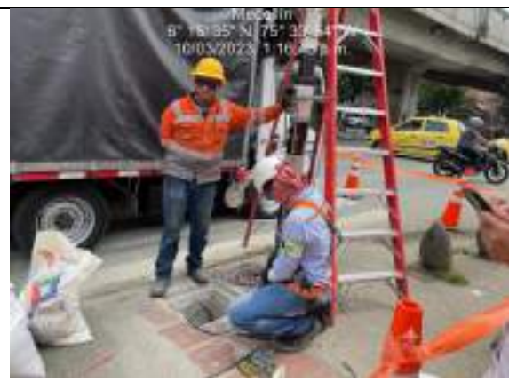
Fotografía 13: Uso de epp
