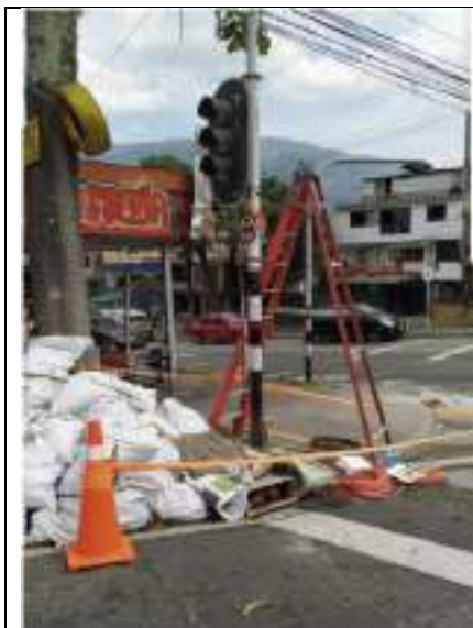
Fotografía 1: Instalación disco direccional carrera 67 con calle 104
