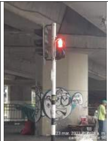
Fotografía 16: Instalación semáforo. Carrera 56C con calle 50
