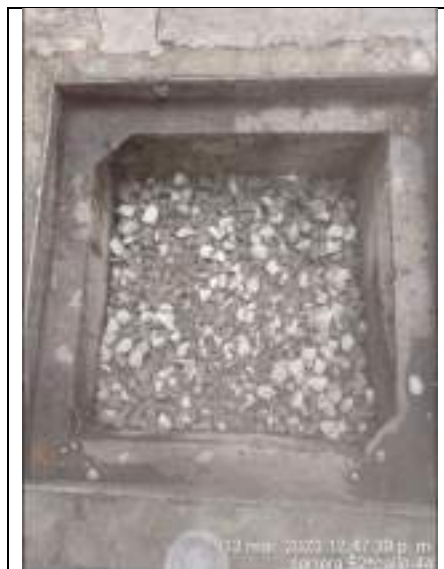
Fotografía 32: Llenada de caja con triturado. Carrera 52 con calle 14
