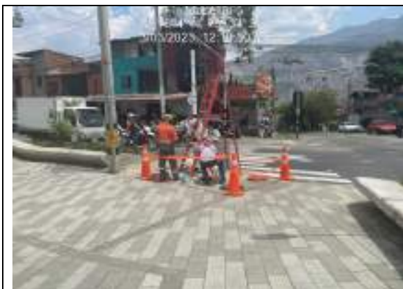
Fotografía 4: Delimitación frentes de trabajo
