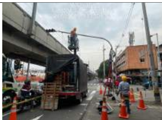
Fotografía 24: Trabajo en alturas
