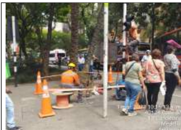
Fotografía 6: Delimitación frentes de trabajo
