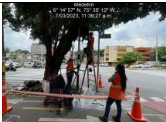
Fotografía 23: Lavado de semáforos y uso de epp anticaídas
