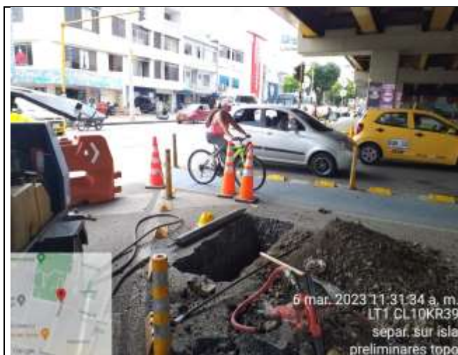
Foto No. 1 Apiques de lanzamiento de topo
