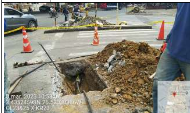
Foto No. 3 Perforación neumática.
