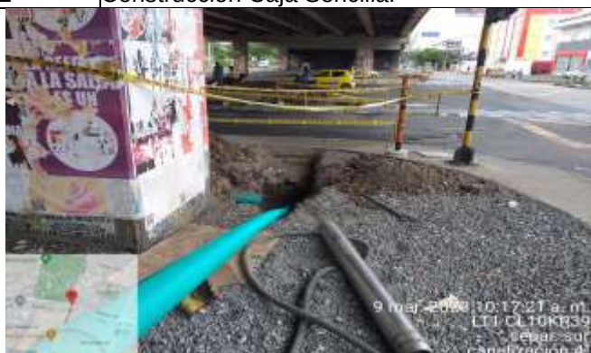
Foto No. 4 Descripción: Canalización con perforación
