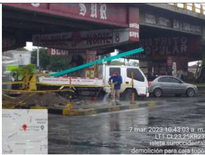
Foto No. 2 Descripción: Demolición de andén Construcción Caja Sencilla.
