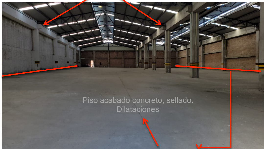
Cerramiento perimetral del área de almacenamiento en mampostería.
