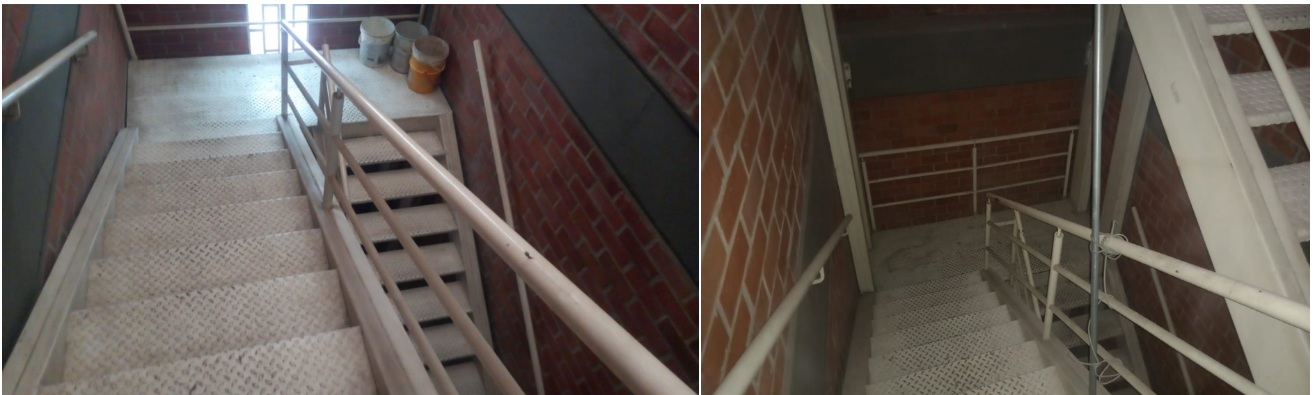
Escalera metálica - liviana Acceso Mezanine - Bodega
