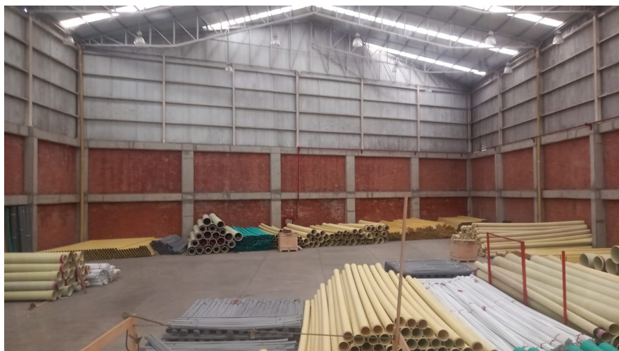
Construcción de Bodega Cubierta a dos aguas Cerramiento completo en muro mampostería
