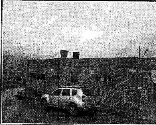
TANQUE DE RESERVA
