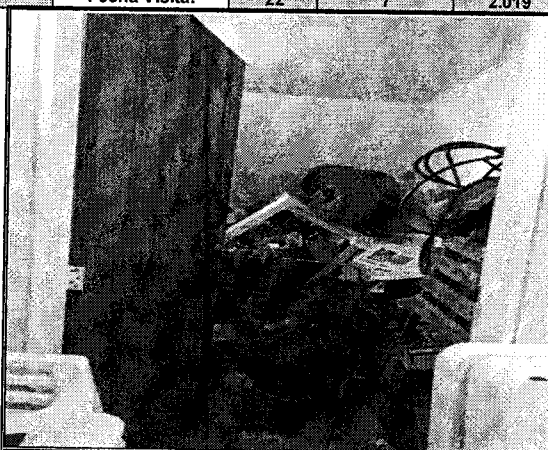
CUARTO DE RESIDUOS
