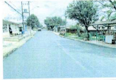
Vía intervenida con instalación de carpeta asfáltica. Calle 1A entre Carreras 41 y 42B. Barrio La María Occidente
