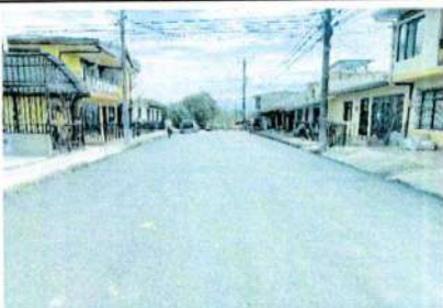
Instalación carpeta asfáltica MDC-19. Carrera 43 entre Calles 1A y 2. Barrio La María Occidente (Comuna 9)
