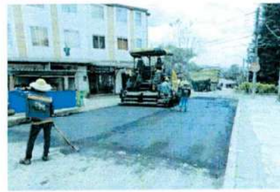
Instalación carpeta asfáltica MDC-19. Carrera 41 entre Calles 1A y 2. Barrio La María Occidente
