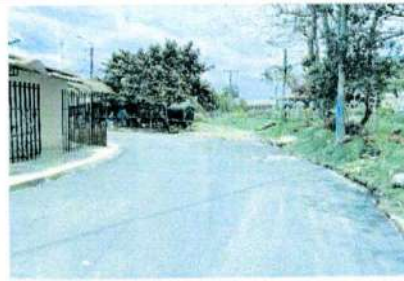
Instalación de mezcla asfáltica MDC-19. Sector curva Carrera 41 con Calle 1. La María Occidente (Comuna 9)
