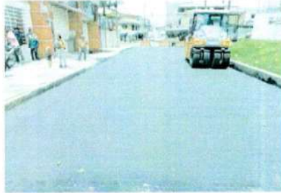
Instalación de mezcla asfáltica MDC-19. Carrera 41 entre Calles 1A y 2. Sector Hospital La María Occidente
