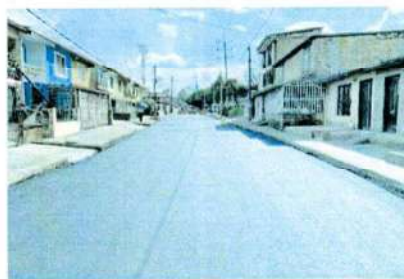
Vía intervenida con instalación de carpeta asfáltica. Carrera 37 entre Calles 2 y 4A. Carlos Primero
