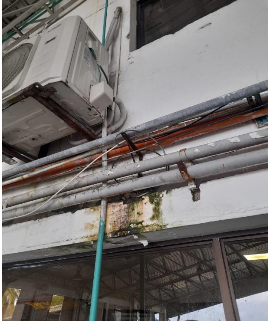
Imágenes 6 y 7. Estado deterioro instalaciones hidrosanitarias y eléctricas.
