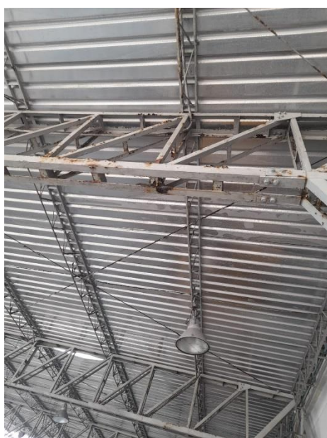
Imágenes 4 y 5. Estado deterioro de la estructura metálica.
