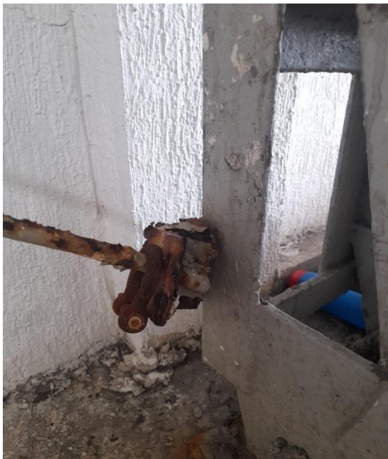
Imágenes 8 y 9. Estado de oxidación estructura metálicas.
