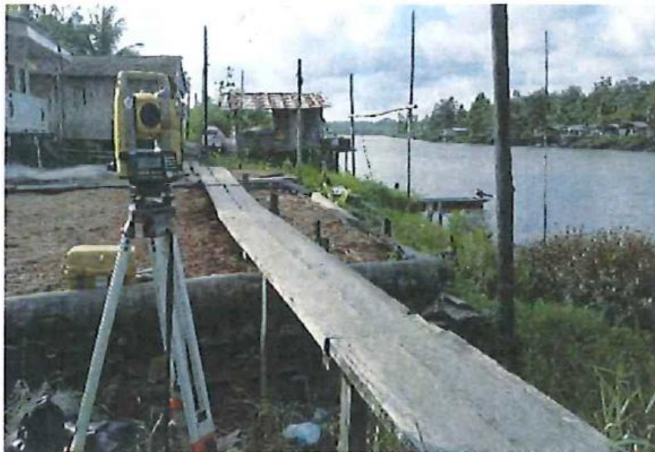
Fotografía 1. Tramo vial a intervenir III Etapa corregimiento Los Brazos, Timbiquí.
