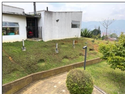
Foto 13. Posible área interna objeto de ampliación de la infraestructura del Jardín Infantil
