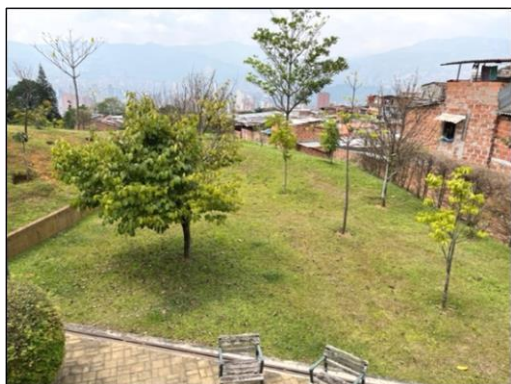
Foto 12. Posible área interna objeto de ampliación de la infraestructura del Jardín Infantil
