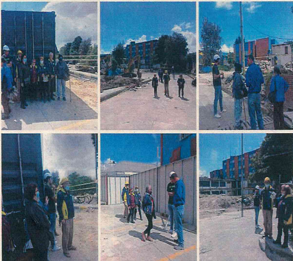
Recorrido obra por los veedores del proyecto amparado por el Convenio 2806257 de 2021
