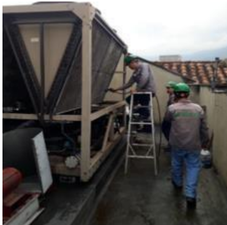
Imagen N° 23. Mtto correctivo y preventivo Chiller York 80 TR.
