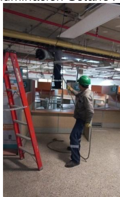
Imagen N° 49. Instalación de cableado de potencia y control para cajas de volumen variable piso 7.
