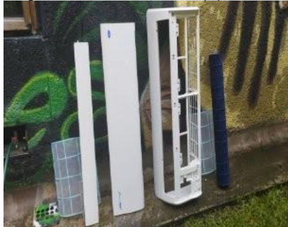
Imagen N° 36. Mtto Preventivo Equipos de AA.
