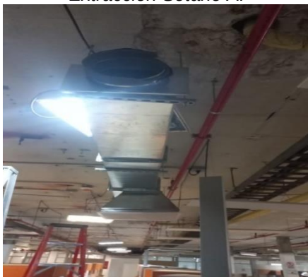
Imagen N° 181. Desinstalación Sistemas de Extracción Sótano A.
