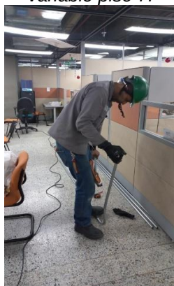
Imagen N° 49. Instalación de cableado de potencia y control para cajas de volumen variable piso 7.
