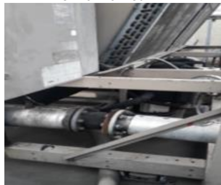
Imagen N° 20. Mtto correctivo y preventivo Chiller York 80 TR.
