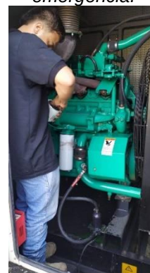
Imagen N° 232. Mantenimiento planta de emergencia.
