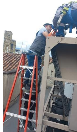
Imagen N° 32. Intervención equipo Chiller.
