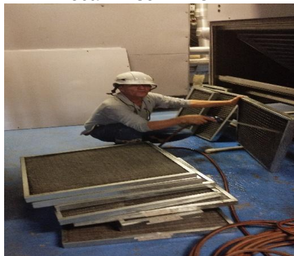
Imagen N° 15. Mtto Preventivo Uma Tecam Piso 11 - CAD.
