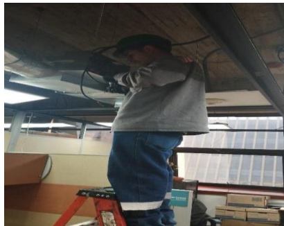
Imagen N° 13. Instalación y Programación del Programador Finder Umas Piso 11 - CAD
