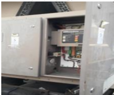
Imagen N° 19. Mtto correctivo y preventivo Chiller York 80 TR.
