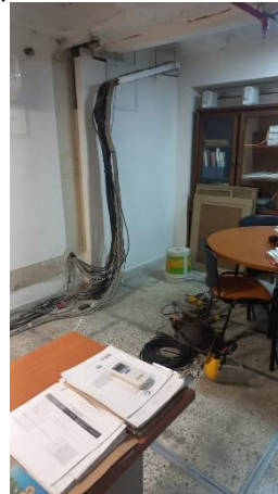
Imagen N° 48172. Retiro de cableado y tubería piso 7.
