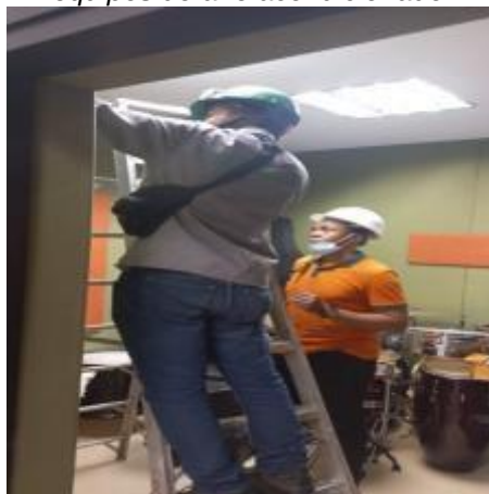
Imagen N° 32. Mantenimiento preventivo equipos de aire acondicionado.
