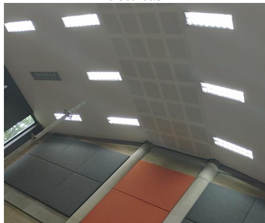
Imagen N°60. Ejecución actividades eléctricas.
