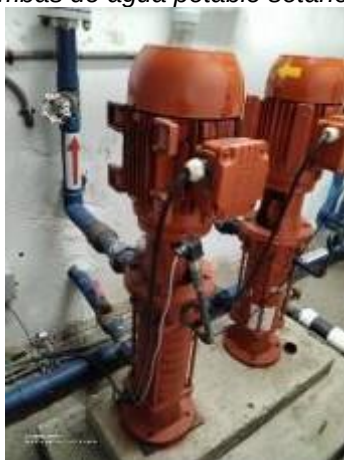
Imagen N° 43. Solicitud mantenimiento bombas de agua potable sótano A.
