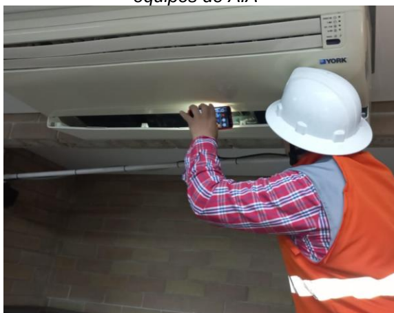
Imagen N° 59. Revisión de mantenimiento de equipos de A.A
