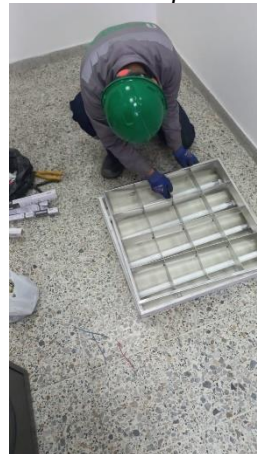
Imagen N° 76. Cambio de tubo fluorescente a tubo led 9W piso 1.
