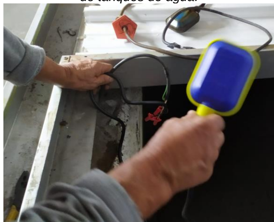
Imagen N° 55178. Pruebas sensores de nivel de tanques de agua.
