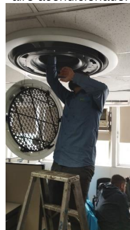
Imagen N° 160. Verificación de punto de instalación de equipo de aire acondicionado.
