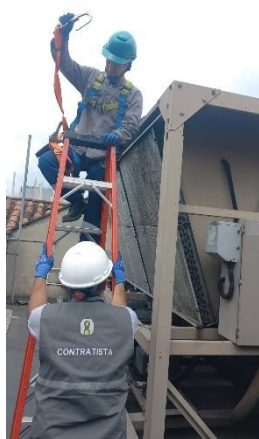
Imagen N°31. Intervención equipo Chiller.
