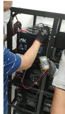
Imagen N° 230. Mantenimiento planta de emergencia.
