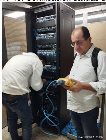
Imagen N°43. Certificación salidas de datos.
