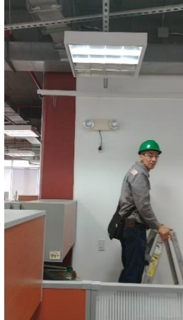
Imagen N° 75. Cambio de tubo fluorescente a tubo led 9W piso 1.
