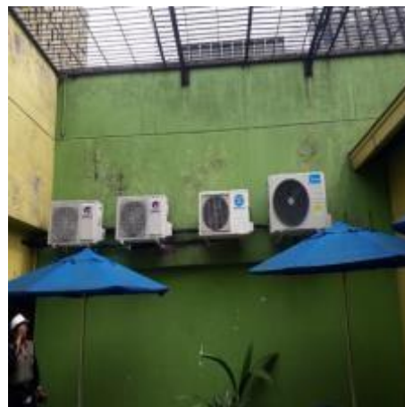
Imagen N° 12. Mantenimiento preventivo equipos AA expansión directa
