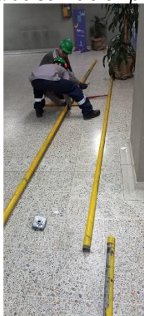
Imagen N° 63. Retiro de elementos eléctricos fuera de servicio en piso 7.
