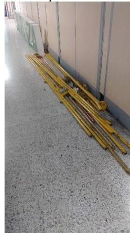
Imagen N° 48172. Retiro de cableado y tubería piso 7.
