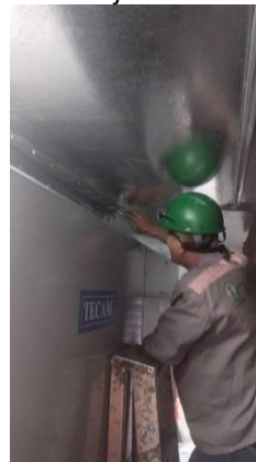
Imagen N° 200. Ajuste Ductería Piso 7.
