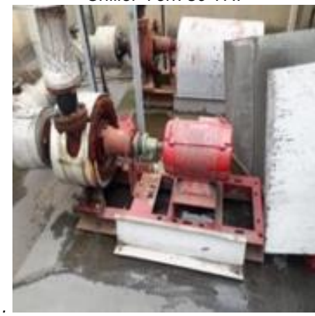
Imagen N° 22. Mtto correctivo y preventivo Chiller York 80 TR.
