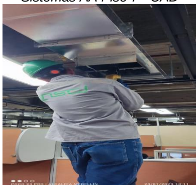
Imagen N° 193. Aislada en Aluminio Tubería Cto Hidráulico Piso 13 - CAD
