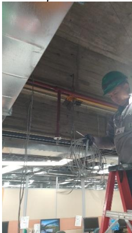
Imagen N° 47. Retiro de cableado y tubería piso 7.
