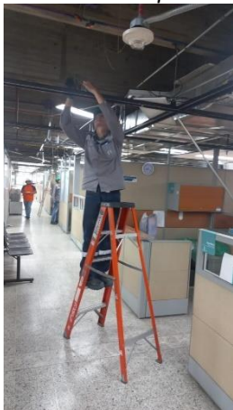
Imagen N° 63. Retiro de elementos eléctricos fuera de servicio en piso 7.
