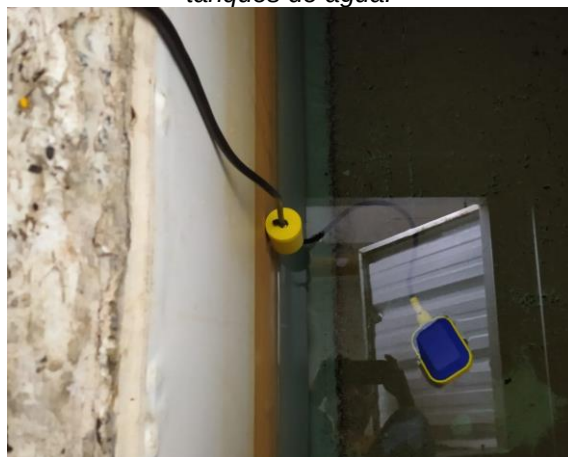
Imagen N°56. Pruebas sensores de nivel de tanques de agua.
