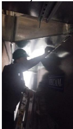
Imagen N° 199. Ajuste Ductería Piso 7.
