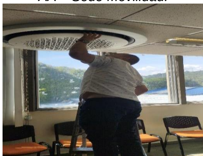
Imagen N° 25. Desinstalación Equipo AA Oficina Movilidad.
