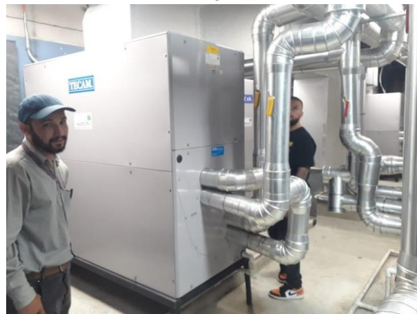
Imagen N° 16. Mantenimiento preventivo UMAS piso 13.
