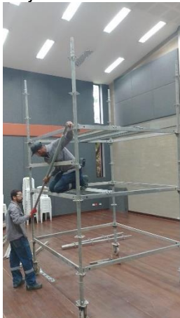
Imagen N°59. Ejecución actividades eléctricas.
