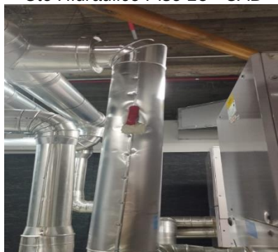
Imagen N° 193. Aislada en Aluminio Tubería Cto Hidráulico Piso 13 - CAD
