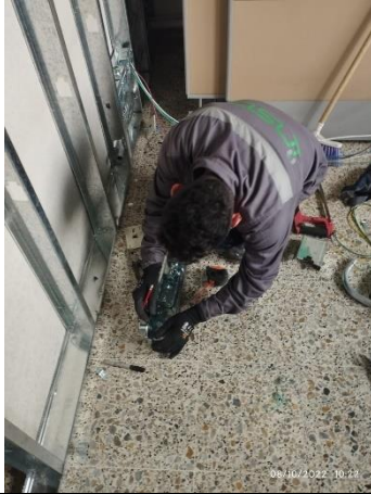
Imagen N° 71. Instalación salidas de iluminación taquillas de espectáculos.
