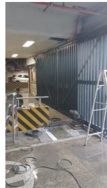
Imagen N° 56. Cambio de motor y adecuación puerta vehicular San Juan.
