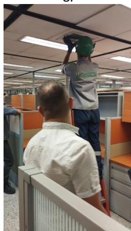
Imagen N° 145. Revisión fugas ductería piso 8.
