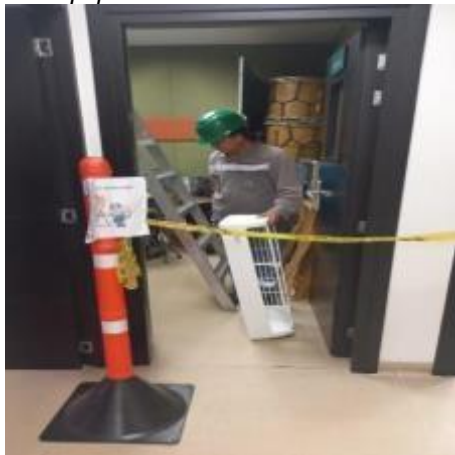
Imagen N° 33. Mantenimiento preventivo equipos de aire acondicionado.
