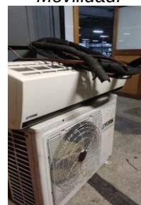
Imagen N° 26. Desinstalación Equipo AA Oficina Movilidad.
