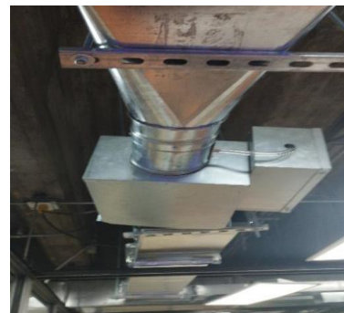
Imagen N° 10. Ajustes CVV Piso 7 – CAD.
