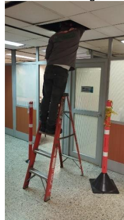
Imagen N° 146. Revisión fugas ductería piso 8.
