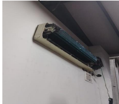
Imagen N° 217. Mtto Preventivo Equipos AA Ofs 3er piso – Edificio Carré.
