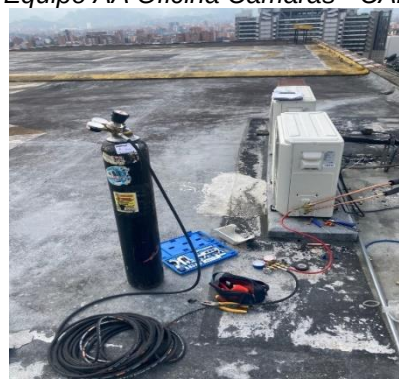
Imagen N° 188. Procedimientos de BPR Equipo AA Oficina Cámaras - CAD
