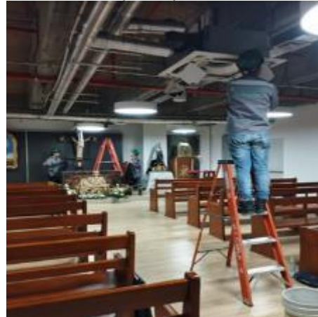
Imagen N° 8. Desmonte de ducteria en lámina fibra de vidrio piso 7.
