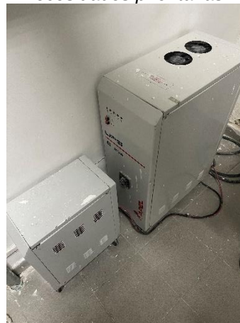
Imagen N° 39. Recorrido para verificar necesidades prioritarias.
