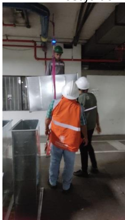
Imagen N° 149. Mantenimiento preventivo UMAS.
