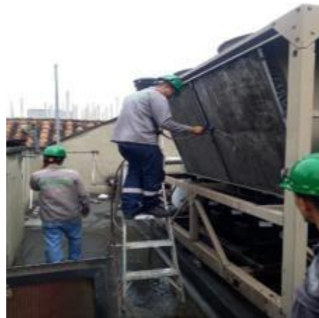
Imagen N° 24. Mtto correctivo y preventivo Chiller York 80 TR.
