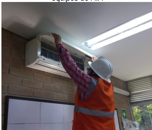
Imagen N° 59. Revisión de mantenimiento de equipos de A.A
