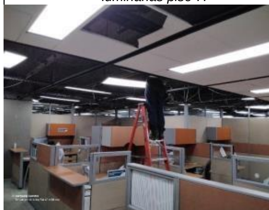
Imagen N° 44. Reubicación y nivelación luminarias piso 7.
