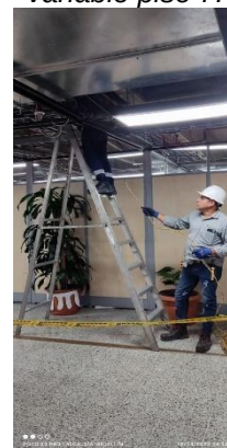
Imagen N° 50. Instalación de cableado de potencia y control para cajas de volumen variable piso 7.
