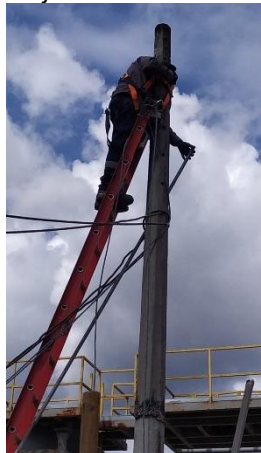
Imagen N°65. Ejecución actividades eléctricas.
