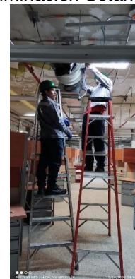
Imagen N° 50. Instalación de cableado de potencia y control para cajas de volumen variable piso 7.
