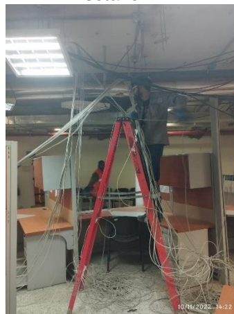
Imagen N° 44. Certificación salidas de datos.
