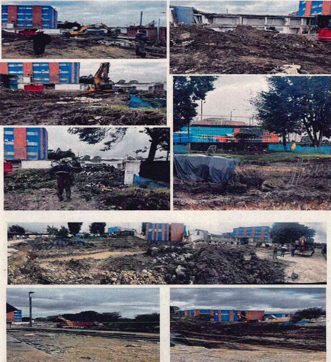
Registro fotográfico de avances marzo 2023 del proyecto amparado por el Convenio 2806257 de 2021
