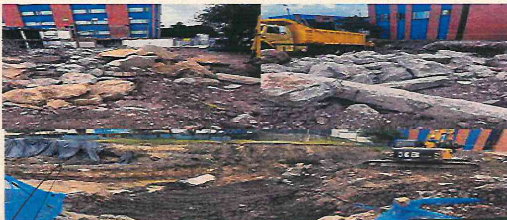
Registro fotográfico de avances marzo 2023 del proyecto amparado por el Convenio 2806257 de 2021
