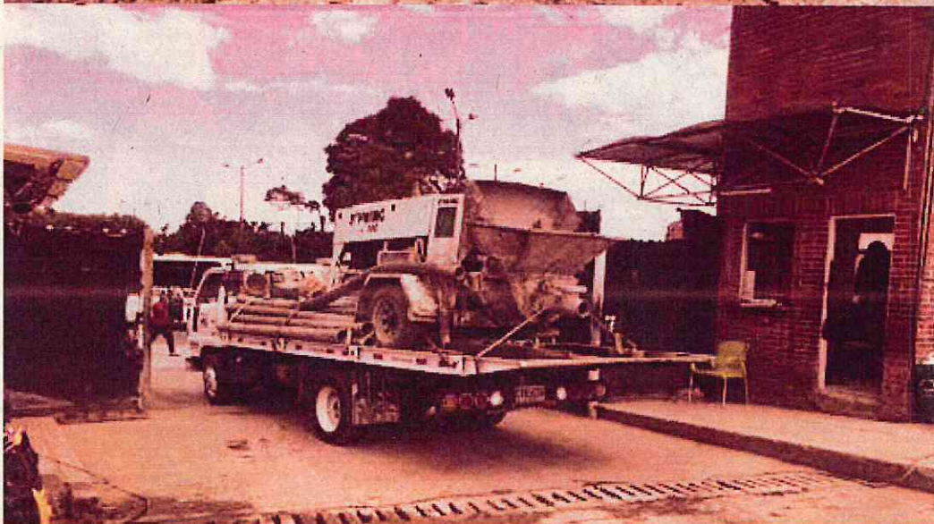
Registro fotográfico de avances abril 2023 del proyecto amparado por el Convenio 2806257 de 2021
