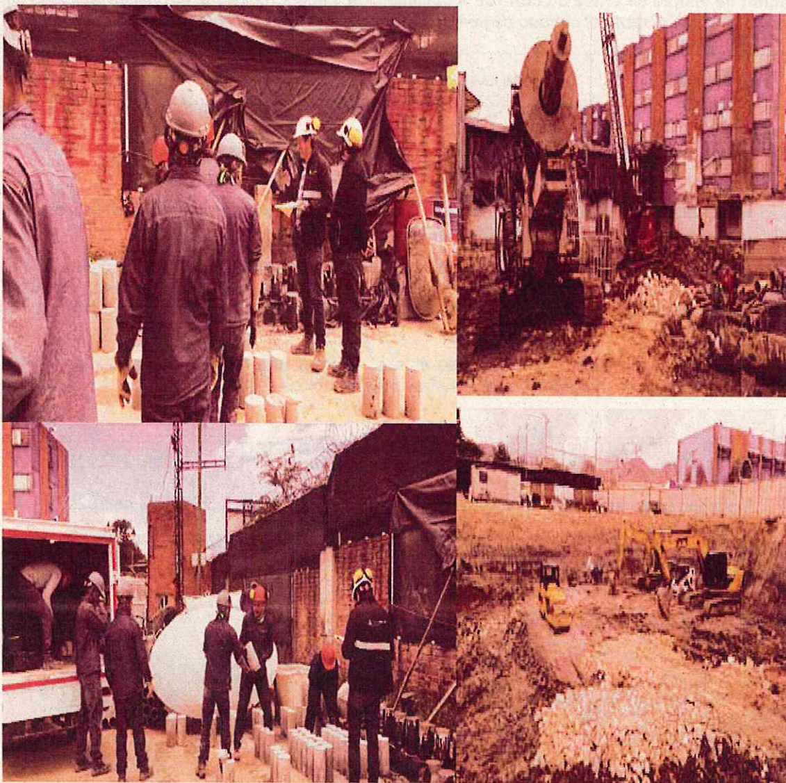
Registro fotográfico de avances abril 2023 del proyecto amparado por el Convenio 2806257 de 2021
