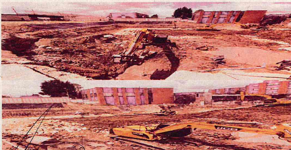
Registro fotográfico de avances abril 2023 del proyecto amparado por el Convenio 2806257 de 2021
