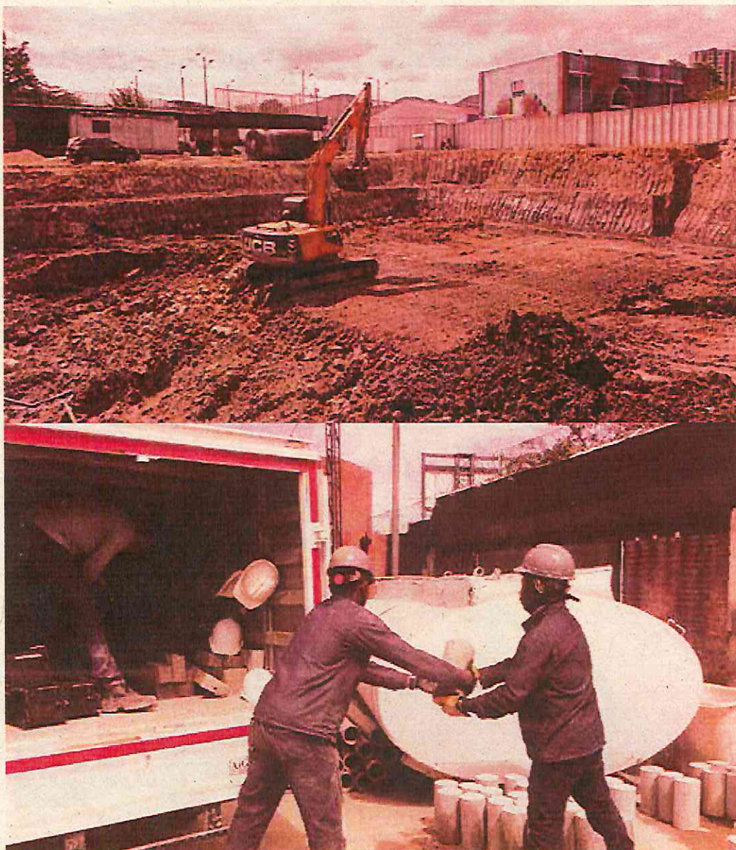
Registro fotográfico de avances abril 2023 del proyecto amparado por el Convenio 2806257 de 2021
