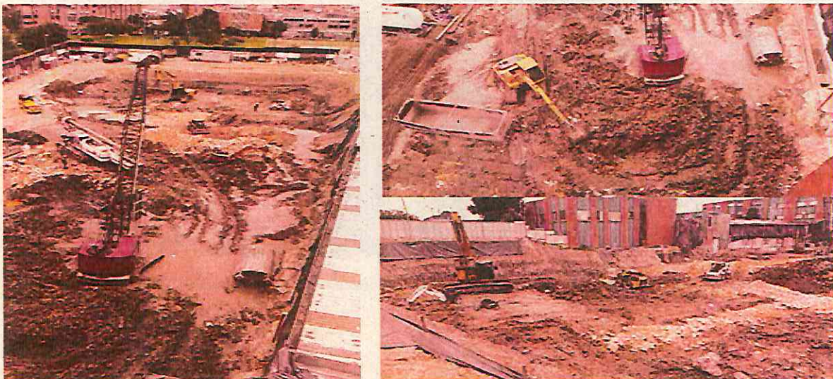
Registro fotográfico de avances abril 2023 del proyecto amparado por el Convenio 2806257 de 2021
