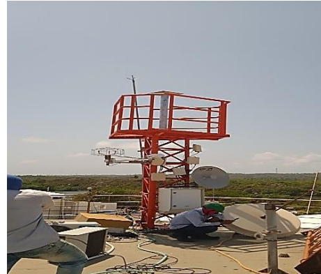
Montaje base radio torre Sistema de Tráfico Marítimo
