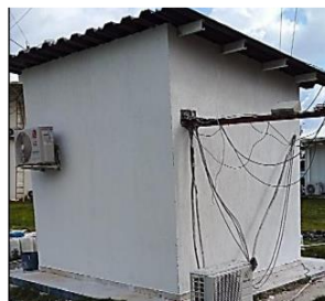
DURANTE Aplique graniplast y sikafil en muros
