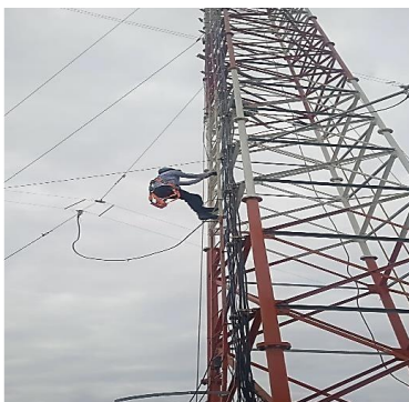
Instalación de refuerzos
