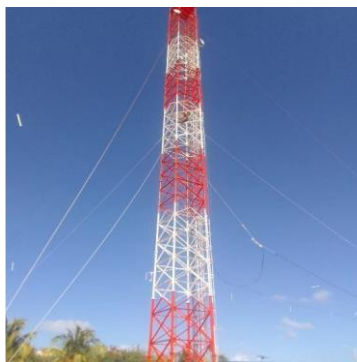
Aplicación de Pintura
