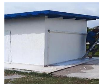
DESPUES Desencofre de placa
