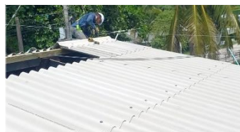
DURANTE Instalación nueva teja
