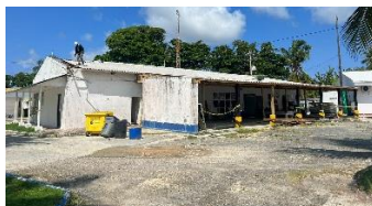
DURANTE Instalación nueva teja
