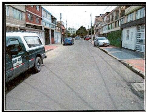
F-05 ESTADO ACTUAL DE LA VIA
