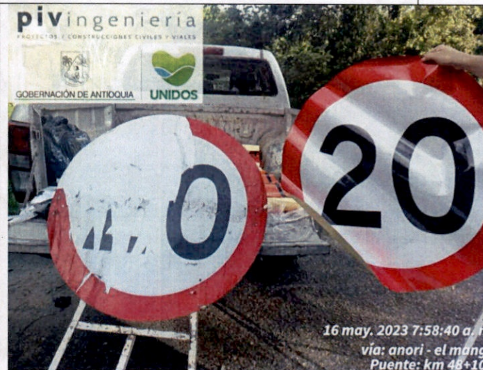
Mantenimiento a Señalización del PMT.
