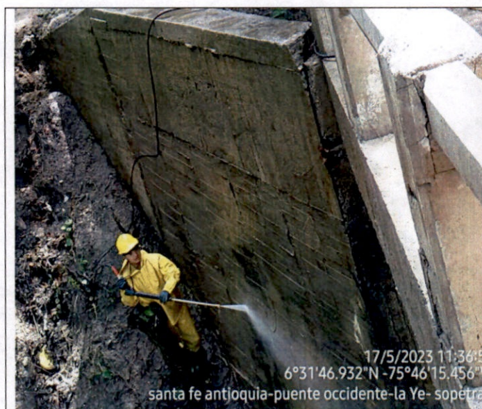
Verificación de trabajo en hidrolavado
