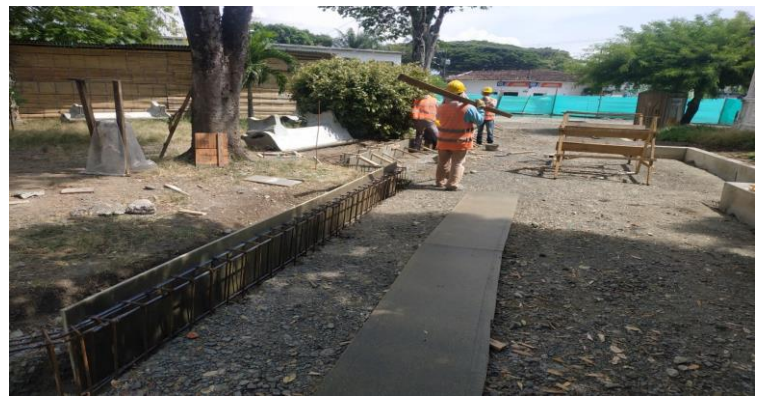
INSTALACIÓN DE FORMALETA PARA MURO DE ZONAS VERDES
