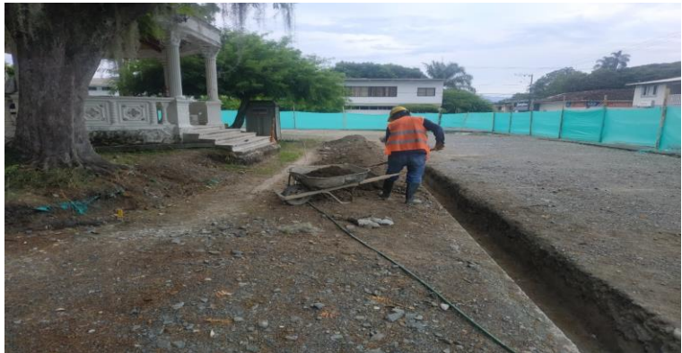
EXCAVACIÓN PARA TUBERIA SANITARIA DE CASITAS
