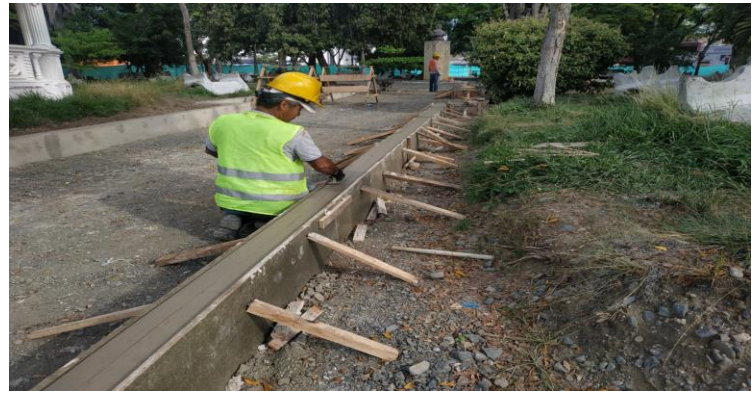
FUNDICIÓN DE MUROS ZONAS VERDES
