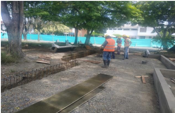
INSTALACIÓN DE FORMALETA PARA MURO DE ZONAS VERDES
