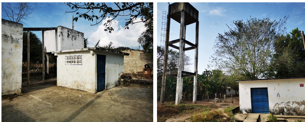
Caseta de bombeo
