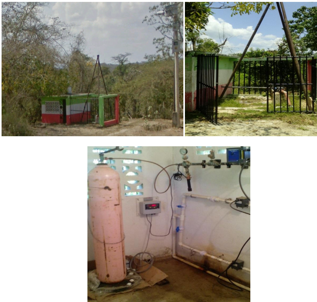
Figura 4. Captación del Sistema de Acueducto de Villa Rosa.
