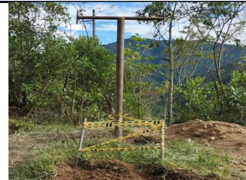
INSTALACIÓN DE POSTE PARA TARABITA
