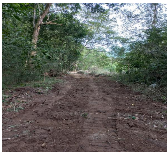
Estado final del terreno de intalación de tubería en zona verde
