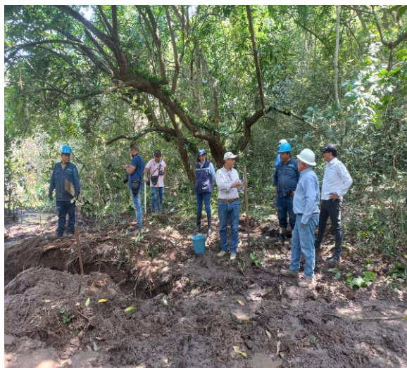
Recorrido Instalación de Tubería de 8" en zona verde
