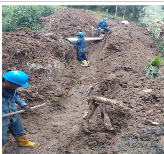
Taponamiento de brecha con material de excavación
