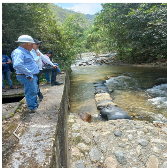
Recorrido a bocatoma de captación del agua quebrada Emaya
