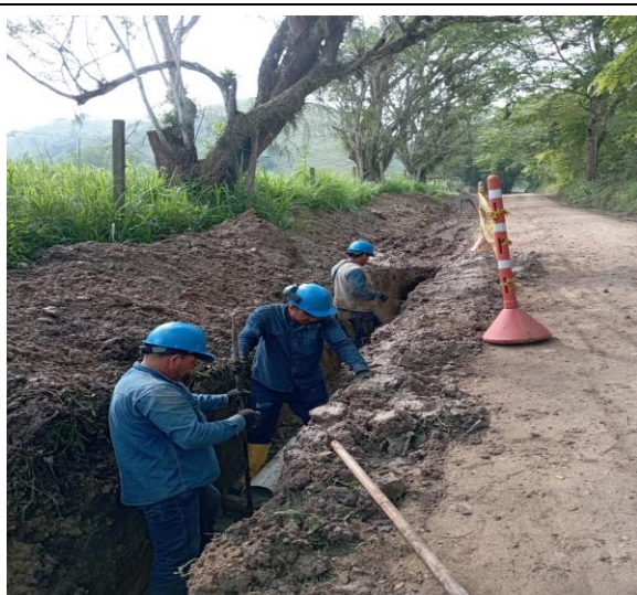
Excavación manual en vía terciaria
