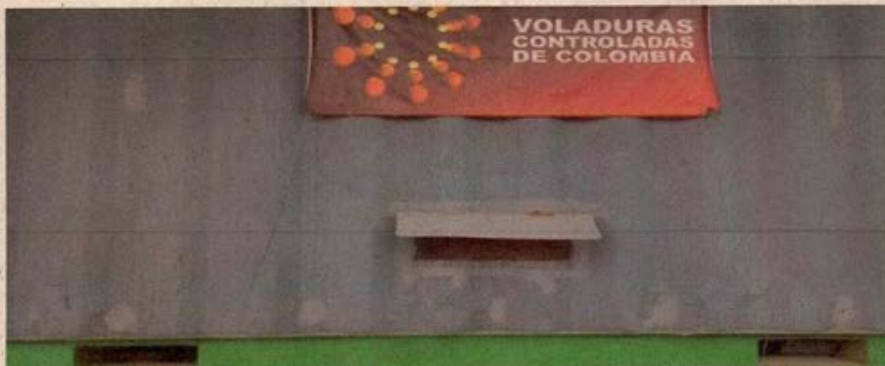
Ilustración 15 Ventilación de Estructuras Portátiles a través de Rejas de Seguridad
