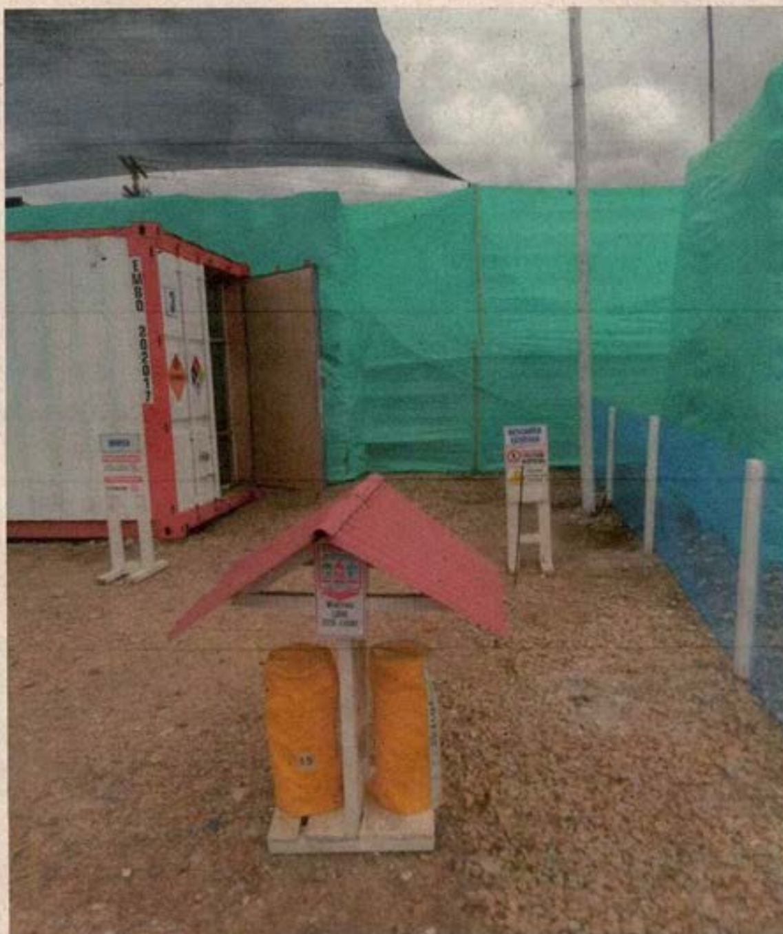
Ilustración 22 Extintores a la entrada de cada polvorín
