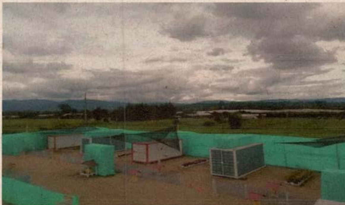
Ilustración 12 – 3 Estructuras Portátiles (polvorines) para Almacenamiento Temporal de Material Pirotécnico Incautado
