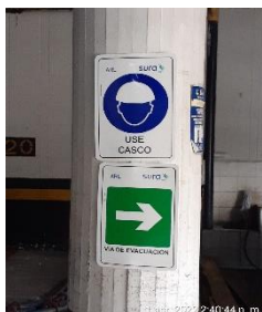
Foto N° 14: Ruta de evacuación a mano izquierda en parqueadero
