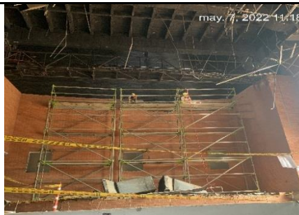
Demolición de muros.
