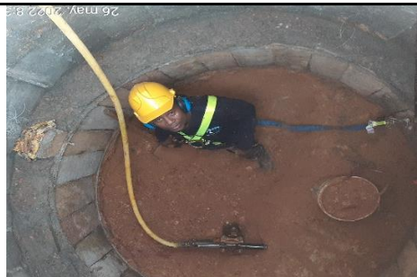
Excavación de pilas.
