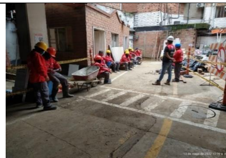
Capacitación técnica practica armada de andamio
