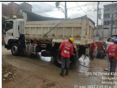
Volqueta en obra.
