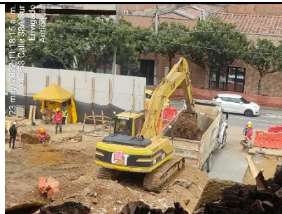
Maquinaria en obra.
