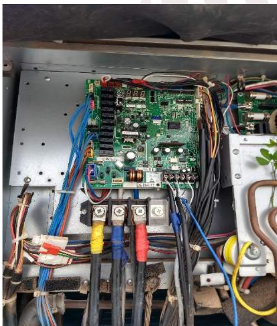
Instalación cable de control unidad condensadora a panel principal
