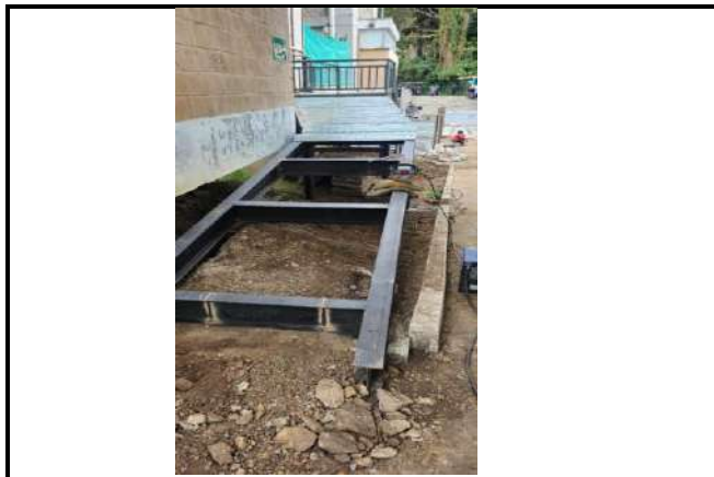
UBICACIÓN: RAMPA 1 COMENTARIOS: INSTALACION Y SOLDADURA DE VIGAS IP 200
