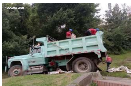
Imagen No 5. Separación en Obra de RCD No Pétreos, El Salitre - Sede A
