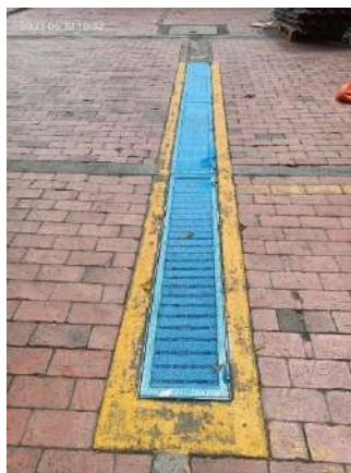
Ilustración 30 . Protección de sumideros aledaños a las instituciones educativas intervenidas, Institución Ramón de Zubiría - Sede A. Fecha: 12 de mayo de 2023
