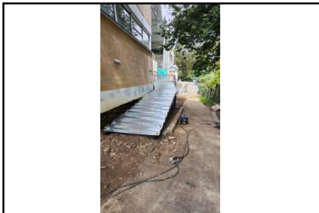
UBICACIÓN: RAMPA 1 COMENTARIOS: INSTALACION DE LAMINA COLABORANTE (STEEL DECK)
