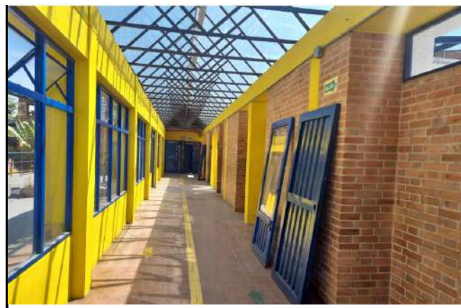
UBICACIÓN: PASILLO BLOQUE 2 COMENTARIOS: DESMONTE PUERTAS METALICAS
