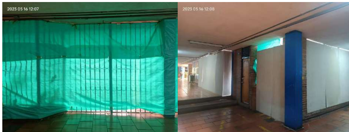
Ilustración 5. Señalización y aislamiento del frente de obra, Alberto Lleras Camargo. Fecha: 16 de mayo de 2023
