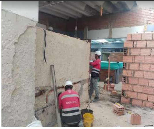
UBICACIÓN: TERCER PISO COMENTARIOS: DEMOLICIÓN DE MURO CENTRAL PARA NUEVO LAVAMANOS
