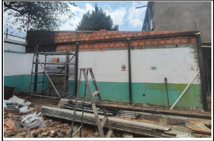
UBICACIÓN: CASA DE UN PISO COMENTARIOS: CONSTRUCCIÓN DE CULATAS EN BLOQUE No 5
