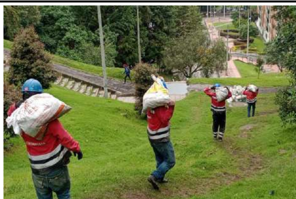
UBICACIÓN: SALIDA DE MATERIAL COMENTARIOS: TRASIEGO DE ESCOMBR
