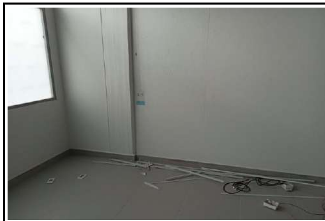
UBICACIÓN: SALONES PISO 1, 2 y 3 COMENTARIOS: DESMONTE DE RED ELECTRICA SOLICITADA A ULTIMA HORA
