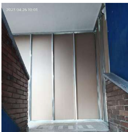
Ilustración 6. Señalización y aislamiento del frente de obra, Juan Lozano y Lozano – Sede A. Fecha: 26 de abril de 2023.
