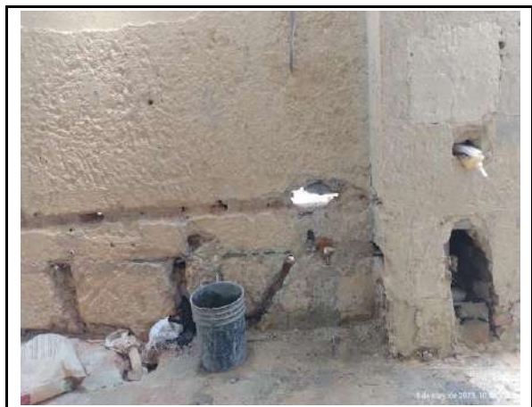
UBICACIÓN: TERCER PISO COMENTARIOS: RETIRO DE TUBERIAS
