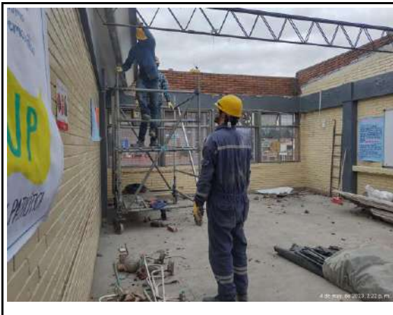
UBICACIÓN: TERCER PISO - AULAS COMENTARIOS: DESMONTE DE CUBIERTAS EN LAS TRES AULAS RECIBIDAS
