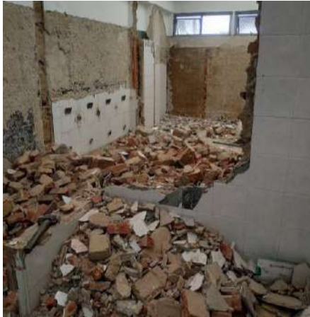
UBICACIÓN: TERCER PISO COMENTARIOS: DEMOLICIONES Y DESMONTES EN 1 BAÑO
