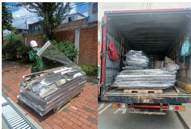
Ilustración 20 Embalaje y recolección de residuos de Fibrocemento para disposición final en la Institución Educativa Ramón de Zubiría – Sede A. Fecha: 6 de mayo del 2023.
