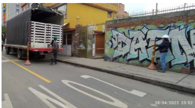
Ilustración 1. Señalización utilizada para el cargue de RCD, el 28 de abril del 2023 en el Colegio Juan Lozano y Lozano – Sede A.
