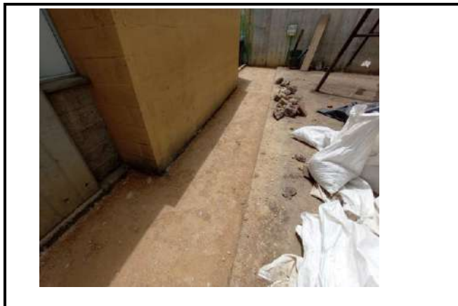
UBICACIÓN: ZONA DE JUEGOS COMENTARIOS: INSTALACION Y COMPACTACION DE RECEBO
