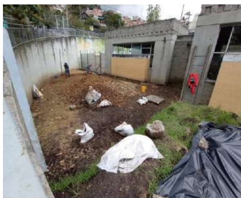
UBICACIÓN: PLAZOLETA DE JUEGOS COMENTARIOS: INSTALACION DE RELLENO B-200
