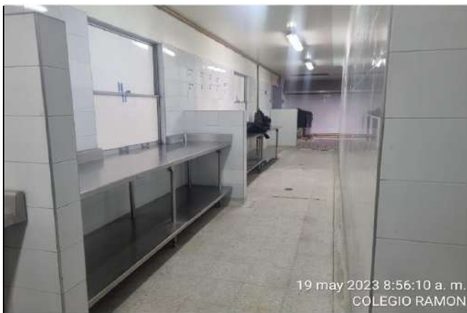
UBICACIÓN: COCINA COMENTARIOS: INSTALACION ENCHAPE
