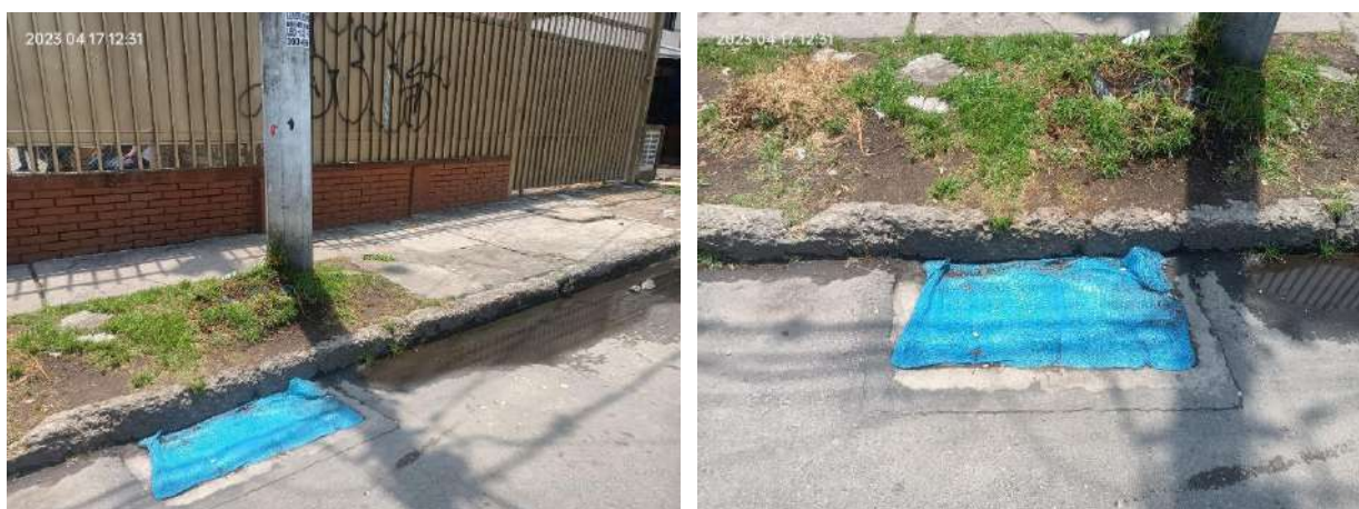
Ilustración 25. Protección de sumideros aledaños a las instituciones educativas intervenidas, Institución Juan Lozano y Lozano - Sede A. Fecha: 17 de abril de 2023.
