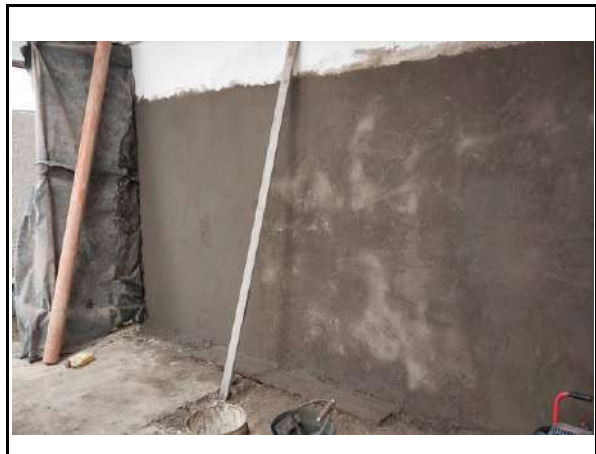
UBICACIÓN: TERCER PISO - BAÑOS COMENTARIOS: AVANCE EN ACTIVIDADES DE PAÑETES
