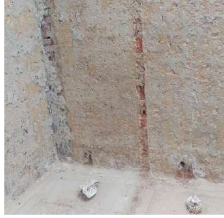
UBICACIÓN: TERCER PISO COMENTARIOS: PICADO DE MUROS Y SUSPENSIÓN DE PUNTOS HIDROSANITARIOS
