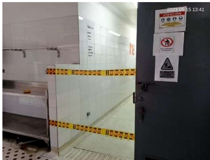
Ilustración 7. Señalización y aislamiento del frente de obra, República Dominicana. Fecha: 12 de mayo de 2023.
