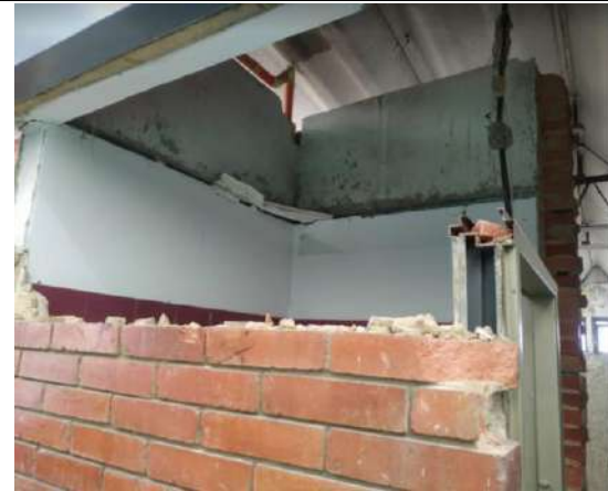
UBICACIÓN: TERCER PISO COMENTARIOS: DESMONTE DE PUERTAS, VENTANAS Y LÁMPARAS DE BAÑO DE PROFESO
