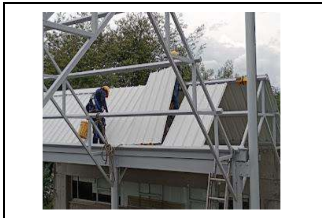
UBICACIÓN: BLOQUE PRESCOLAR COMENTARIOS: COLOCACION DE TEJAS UPVC Y PINTURA DE ESTRUCTURA METALICA
