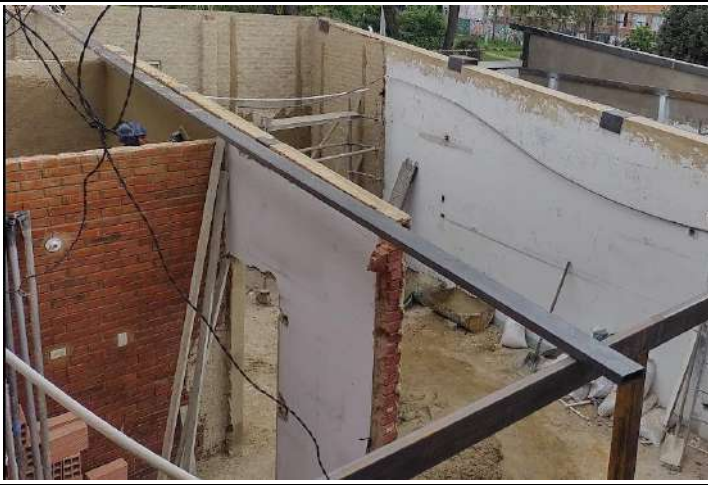
UBICACIÓN: SALA DE PROFESORES COMENTARIOS: DEMOLICIÓN DE MUROS PARA AMPLIACIÓN DEL ESPACIO
