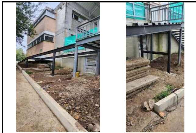
UBICACIÓN: RAMPA 1 COMENTARIOS: INSTALACION DE COLUMNAS EN TUBO DE ACERO Y VIGAS IP 200
