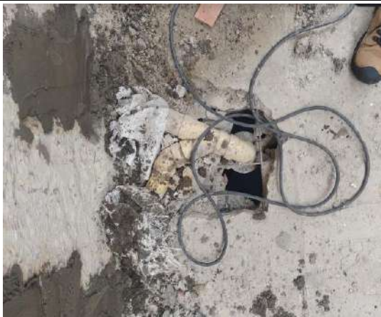
UBICACIÓN: TERCER PISO - BAÑOS COMENTARIOS: RETIRO DE TUBERIA HIDROSANITARIA
