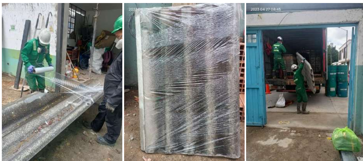
Ilustración 17 Embalaje y recolección de residuos de Fibrocemento para disposición final en la Institución Educativa Nueva Zelandia – Sede A. Fecha: 27 de abril del 2023
