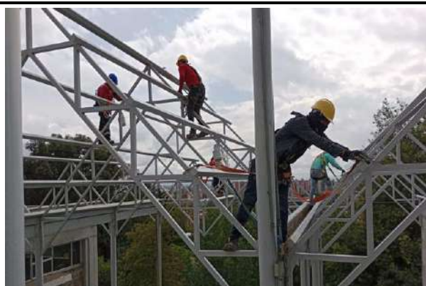
UBICACIÓN: BLOQUE PRESCOLAR COMENTARIOS: DESMONTE DE TEJA EXISTENTE
