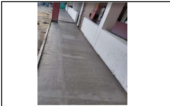
UBICACIÓN: EDIFICIO NORTE - PRIMER PISO COMENTARIOS: ALISTADO DE PISO DE PASILLO FRENTE A SALONES
