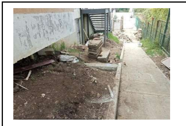
UBICACIÓN: SENDERO PEATONAL CENTRAL COMENTARIOS: EXCAVACION PARA CONSTRUCCION DE VIGA
