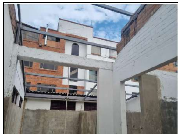
UBICACIÓN: BAÑO NIÑOS COMENTARIOS: DESMONTE CUBIERTA
