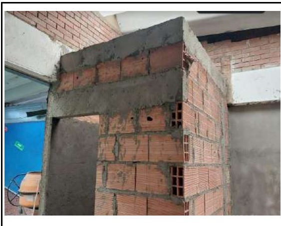
UBICACIÓN: TERCER PISO - BAÑOS COMENTARIOS: ELEMENTOS DE CONCRETO REFORZADO - CONFINAMIENTO DE MUROS NUEVOS
