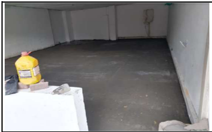
UBICACIÓN: EDIFICIO NORTE PRIMER PISO COMENTARIOS: ALISTADO DE PISO AULA DE SISTEMAS
