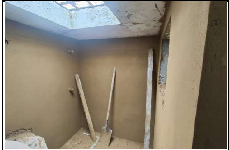
UBICACIÓN: CASA DE DOS PISOS COMENTARIOS: PAÑETES SOBRE MUROS DE BAÑO
