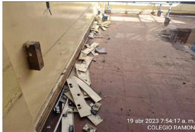
UBICACIÓN: SALON DE INFORMATICA - BLOQUE 2 COMENTARIOS: DESMONTE RED ELECTRICA
