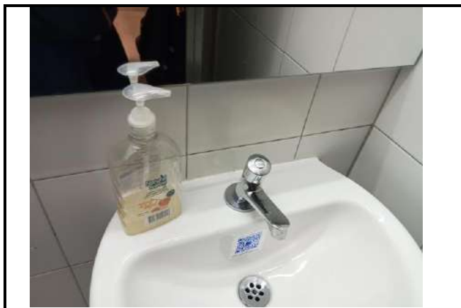
UBICACIÓN: BAÑO VIGILANCIA COMENTARIOS: INSTALACION DE GRIFERIA TIPO PUSH
