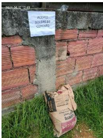
Ilustración 23 Acopio de bolsas de cemento en la Institución Educativa Hunza – Sede B. Fecha: 10 de abril del 2023
