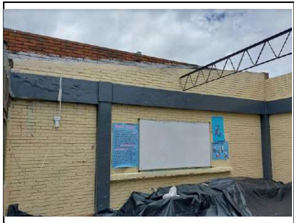
UBICACIÓN: TERCER PISO - AULAS COMENTARIOS: DEMOLICIÓN DE ENCOROZADO DE CUBIERTA
