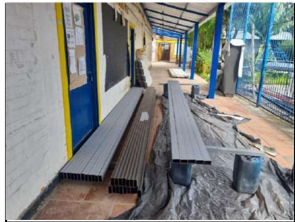
UBICACIÓN: PASILLO COMENTARIOS: PINTURA DE CERCHAS CON ANTICORROSIVO
