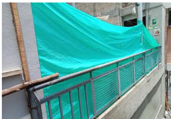
UBICACIÓN: BLOQUE PRIMARIA COMENTARIOS: INSTALACION DE CERRAMIENTO EN LONA VERDE
