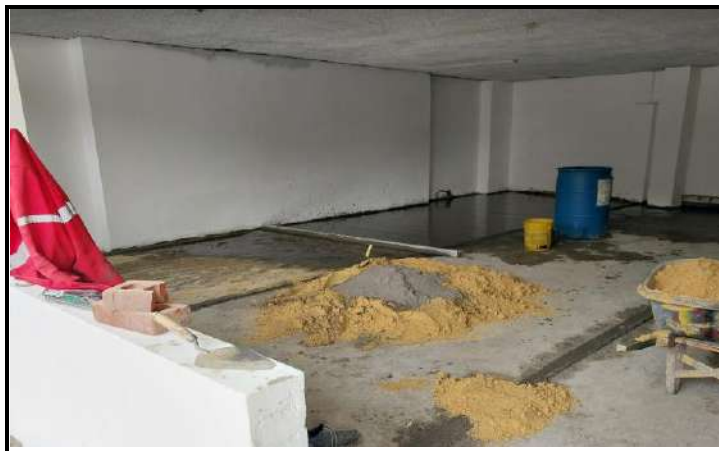
UBICACIÓN: EDIFICIO NORTE - PRIMER PISO COMENTARIOS: IPROCESO DE ALISTADO DE PISO
