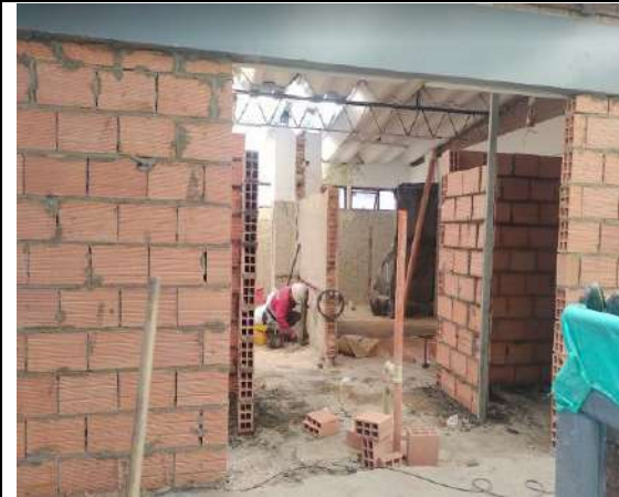
UBICACIÓN: TERCER PISO COMENTARIOS: CONSTRUCCIÓN DE MUROS EN BLOQUE No.5 SEGÚN DISEÑO
