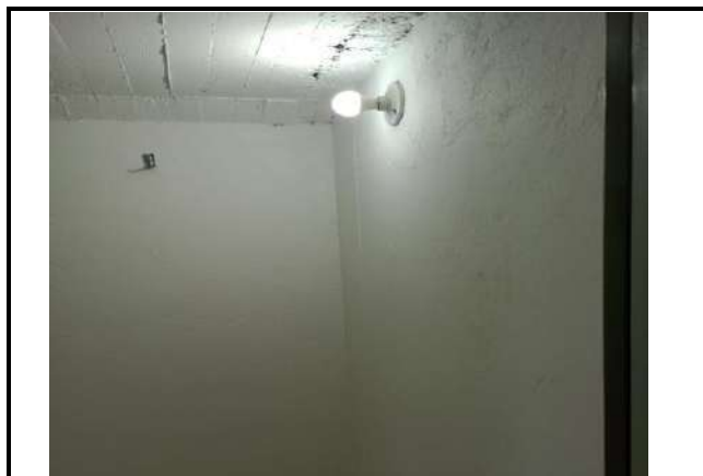
UBICACIÓN: BODEGA PISO 1 COMENTARIOS: PINTURA DE MUROS CON VINILO SOLICITADA A ULTIMA HORA
