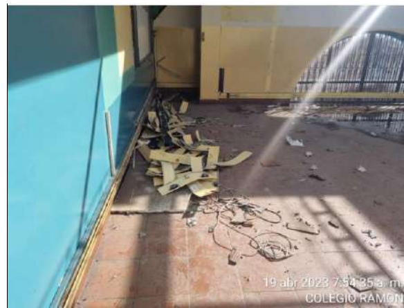
UBICACIÓN: SALON DE INFORMATICA 2 - BLOQUE 2 COMENTARIOS: DESMONTE RED ELECTRICA
