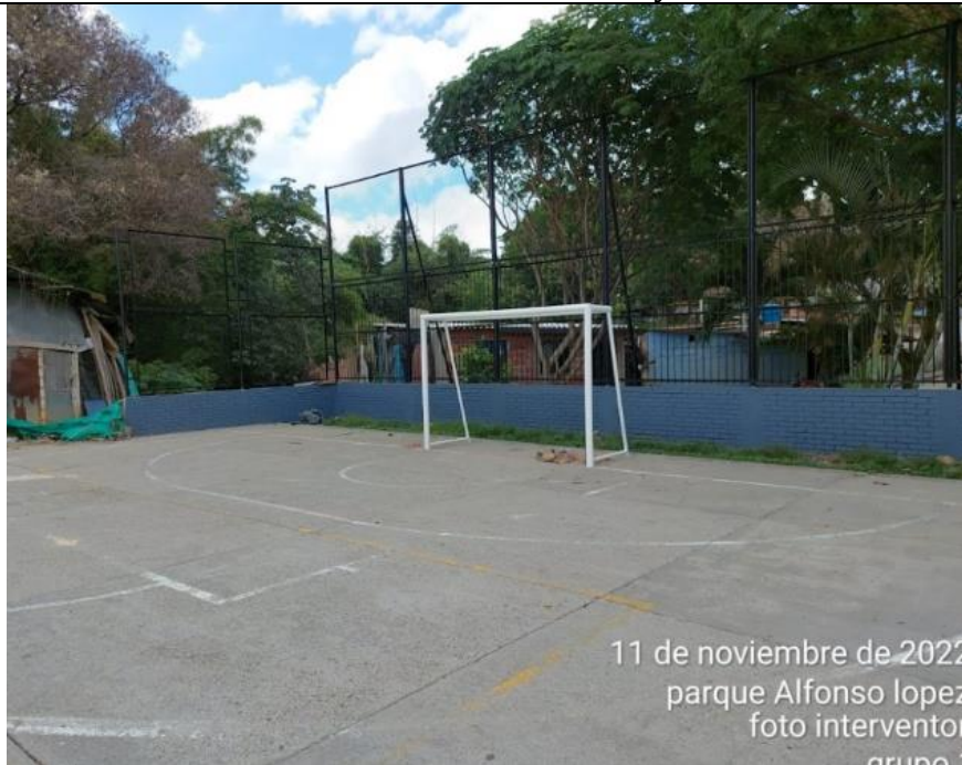
Mantenimiento de Arcos de football y cerramiento
