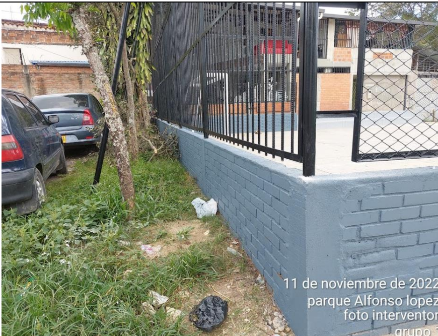
Pintura del cerramiento
