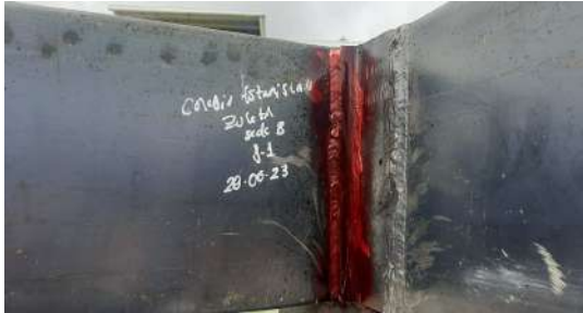
APLICACIÓN DE PENETRANTE
