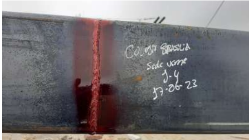
APLICACIÓN DE PENETRANTE
