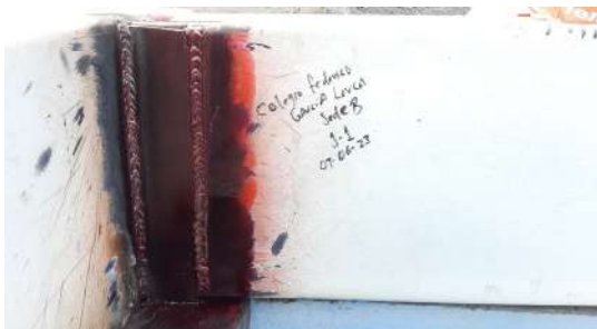
APLICACIÓN DE PENETRANTE
