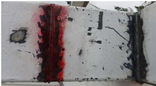
APLICACIÓN DE PENETRANTE
