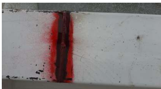
APLICACIÓN DE PENETRANTE
