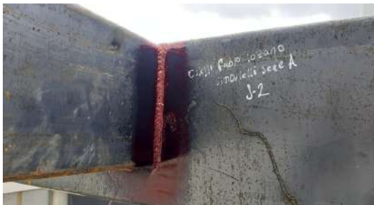
APLICACIÓN DE PENETRANTE
