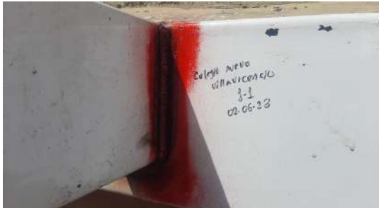
APLICACIÓN DE PENETRANTE
