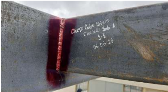
APLICACIÓN DE PENETRANTE
