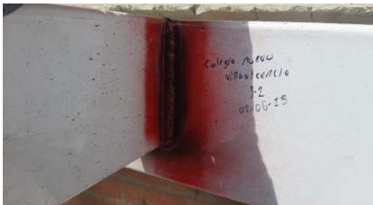
APLICACIÓN DE PENETRANTE
