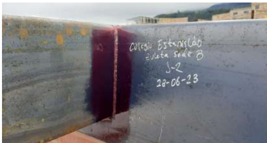
APLICACIÓN DE PENETRANTE
