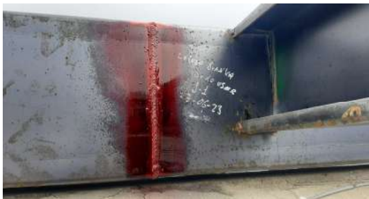
APLICACIÓN DE PENETRANTE
