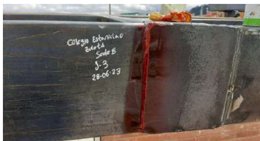
APLICACIÓN DE PENETRANTE
