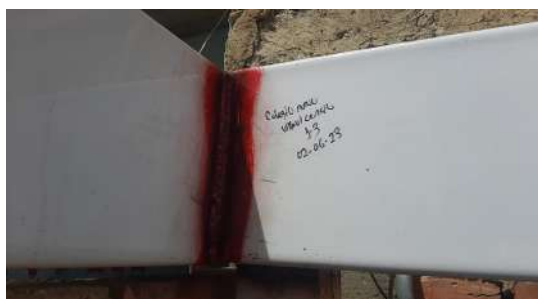
APLICACIÓN DE PENETRANTE
