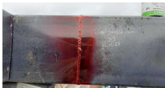
APLICACIÓN DE PENETRANTE
