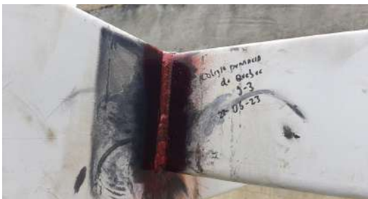
APLICACIÓN DE PENETRANTE
