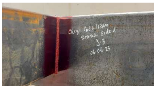
APLICACIÓN DE PENETRANTE
