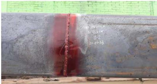
APLICACIÓN DE PENETRANTE
