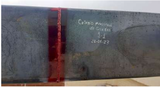
APLICACIÓN DE PENETRANTE
