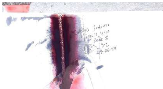
APLICACIÓN DE PENETRANTE
