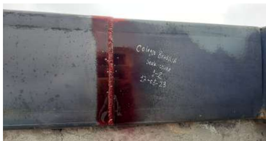
APLICACIÓN DE PENETRANTE
