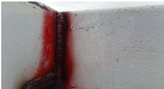
APLICACIÓN DE PENETRANTE
