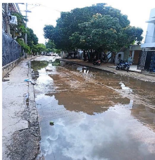
Inspección del estado de la vía
