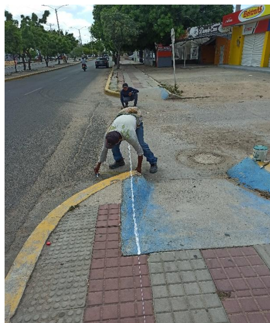
Marcación con pintura del Eje
