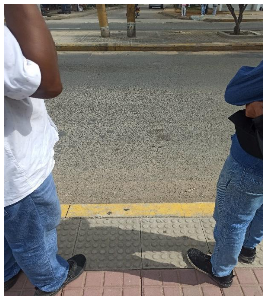
Inspección en la calle 15
