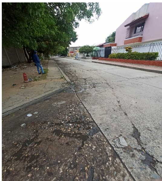
Inspección en la calle 16b
