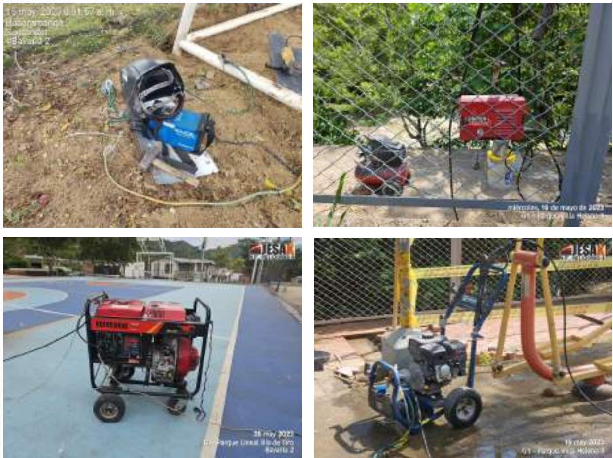
Figura 13. Maquinaria en Obra
