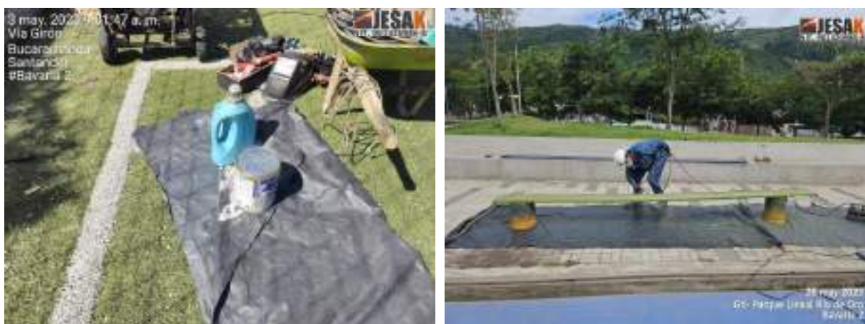
Figura 6 Uso de Sustancias Químicas en Obra
