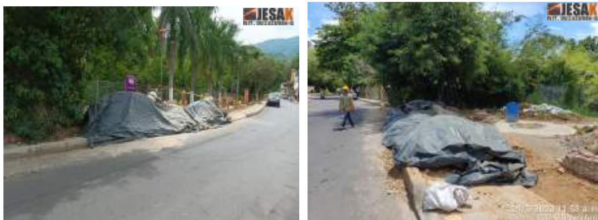
Figura 4 Acopio de Material Pétreo
