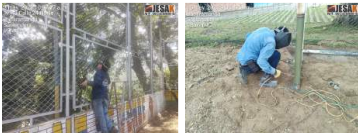
Figura 12 Procedimientos en obra
