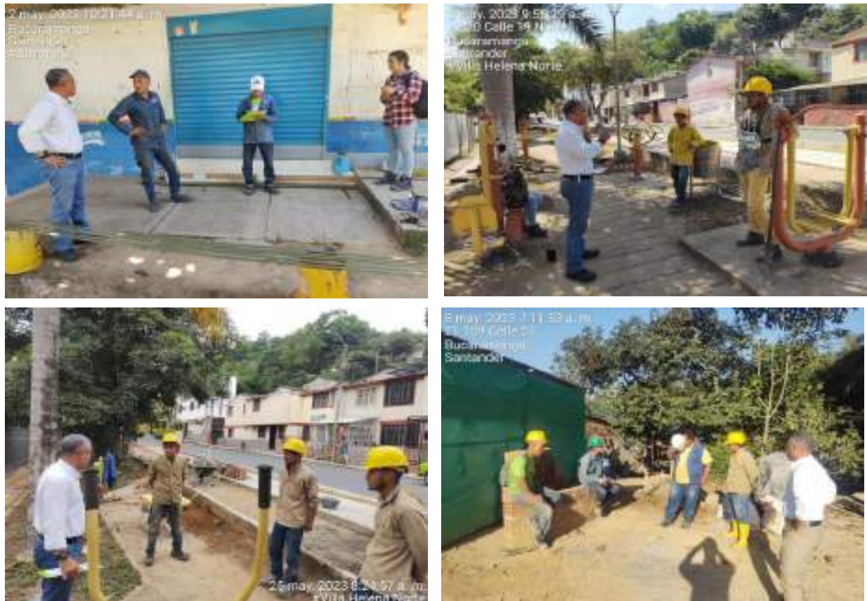
Figura 8 Registro fotográfico Capacitaciones Contratista
