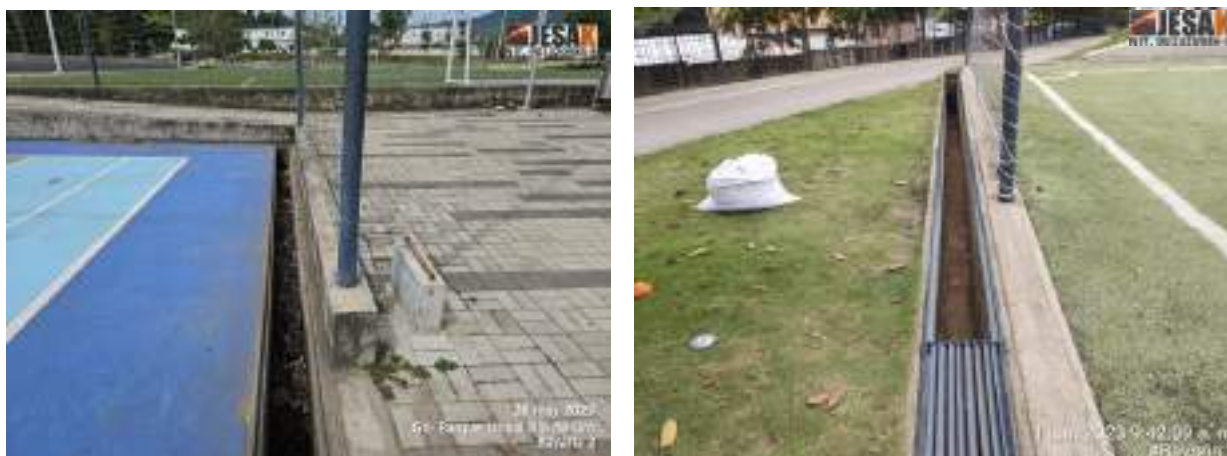
Figura 7 Limpieza de canaletas
