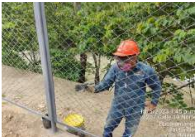
Figura 14. Inspección elementos de protección personal
