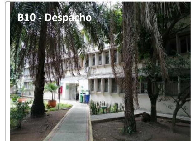
Fotografía 7. Bloque No. 10 Administrativo - Despacho Regional
