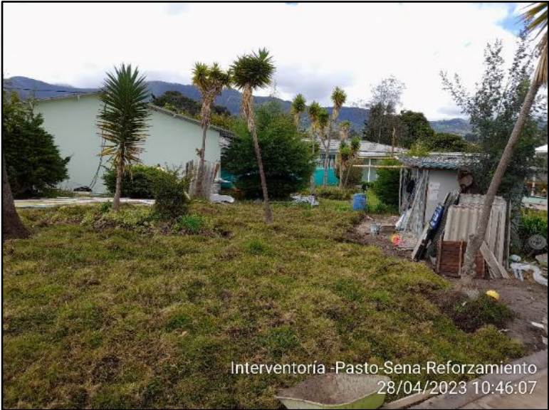
Adecuación de zona verde y desmonte de campamento
