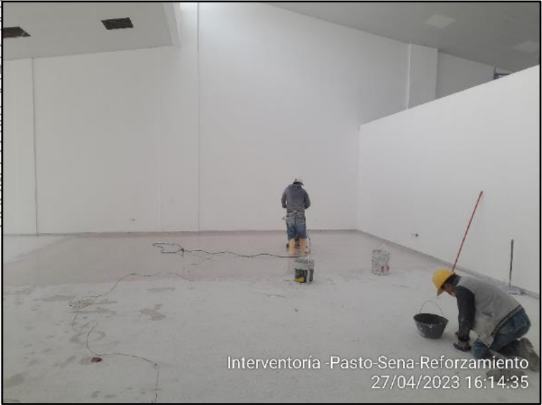
Acabado final de piso con Baldosa en grano de mármol vibropresado 33x33 cm, Blanco Huila
