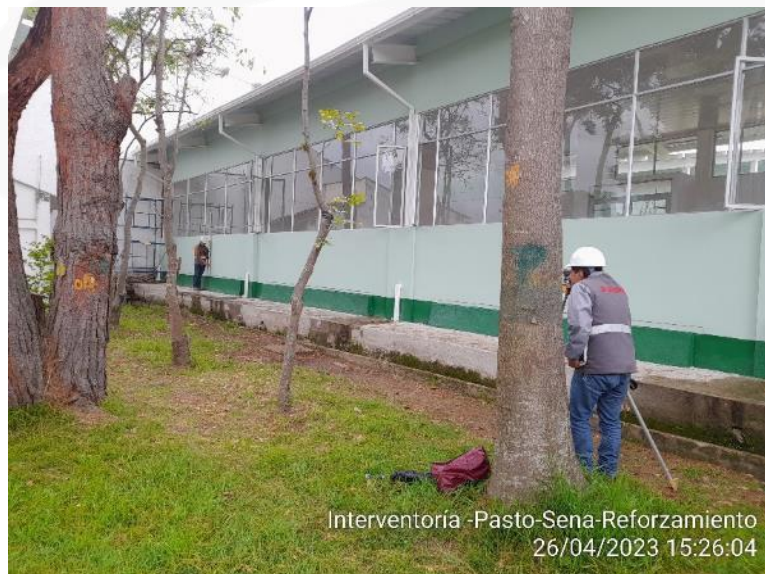
Control de asentamiento con equipo de topografía
