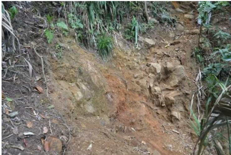
Figura 32. Tramo para construcción de muro
