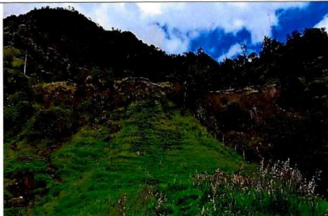
Fotografía 1. Vista desde la casa del señor Fanor Dimate Palacios donde se evidencia el proceso de movimiento en masa a lo largo de la ladera.
