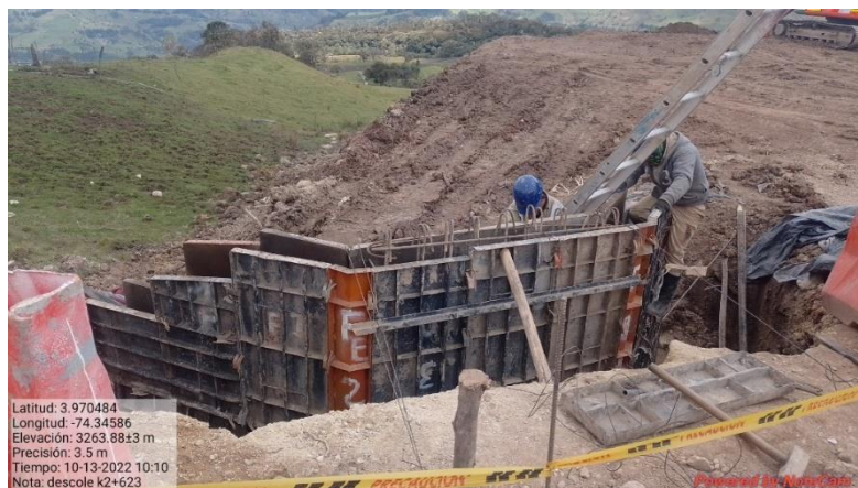
Figura 17- Acero de refuerzo alcantarilla k2+623
