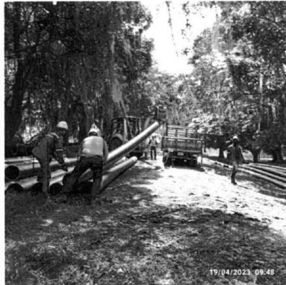
Fotografía 52. Trasiego de tubería PEAD de 14"
