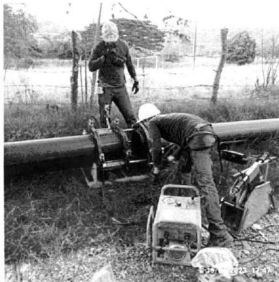
Fotografía 53. Pega de tubería PEAD 14" por Termofusión
