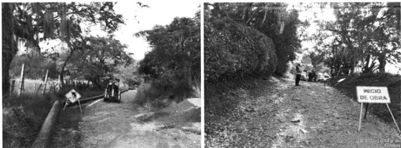
Ilustración 20 Señal vial instalada Tramo 3
