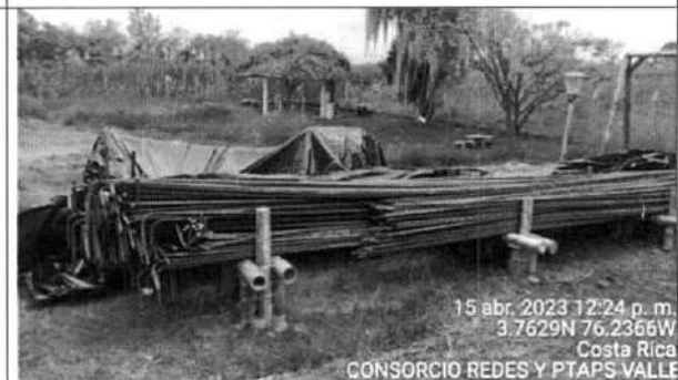
Fotografía 20. Continúa construcción de estructura madera (burros) para organización y traslado de acero.
