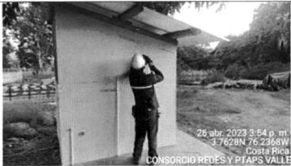
Fotografía 43. Se instala estructura Dry-Wall, perfiles para instalar lamina superboard, para construcción de muros de para los baños provisionales de la obra.
