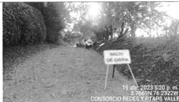
Fotografía 29. Instalación de señalización PMT para instalación de tubería en el tramo No. 03 (14" de Diámetro).
