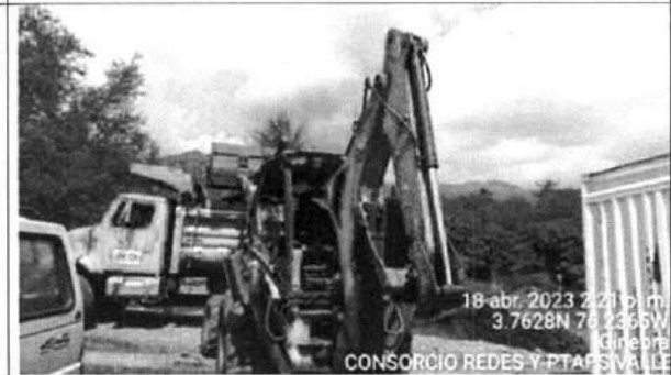
Fotografía 22. Continúa retiro de material sobrante a lugar autorizado (Material Acopiado para utilizarlo en relleno de tubería).
