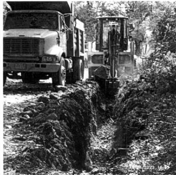
Fotografía 54. Excavación mecánica
