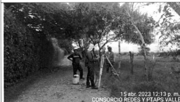
Fotografía 19. Continúa la comisión de topografía con el trazado de la línea de conducción del tramo 3.
