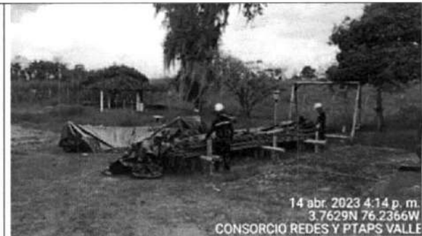
Fotografía 18. Continúa la construcción de estructura madera (burros) para organización y traslado de acero.
