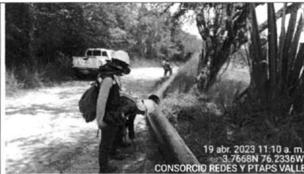
Fotografía 30. Se realiza instalación de tubería sanitaria para instalación de los baños provisionales.
