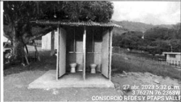
Fotografía 44. Se instala estructura Dry-Wall, perfiles para instalar lamina superboard, para construcción de muros de para los baños provisionales de la obra.
