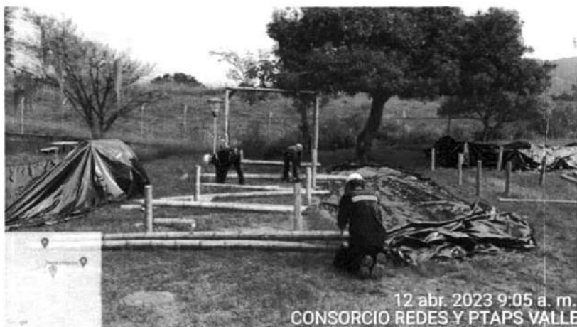
Ilustración 22 Cubrimiento y aislamiento de acero de refuerzo
