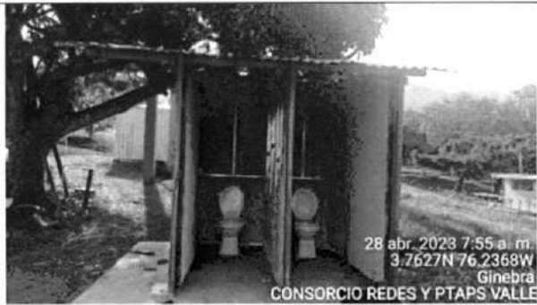
Fotografía 45. Se realiza la puesta en servicio de los baños provisionales de la obra.
