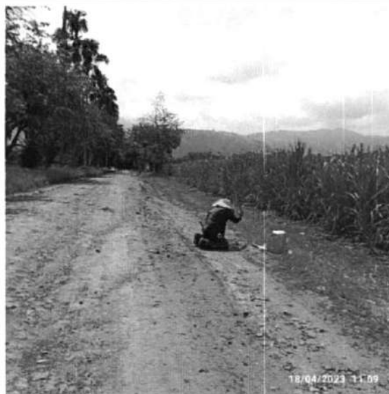
Fotografía 48. Comision de Topografia poniendo estacas
