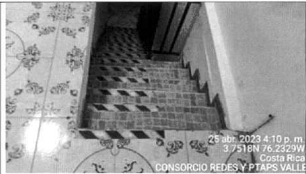
Fotografía 42. se realiza instalación en la oficina de Camilla, botiquín, extintor y cinta antideslizante sobre las escalera con el objetivo de prevenir una caída.
