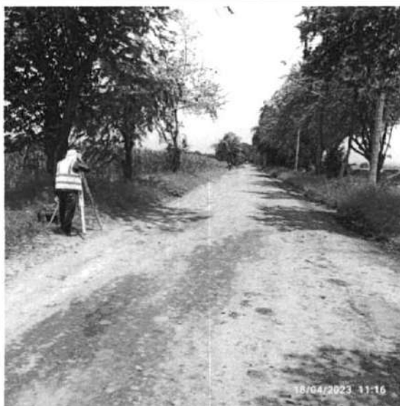
Fotografía 47. Comision de Topografia localizando tramo 3
