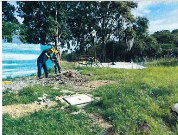
Fotografía 41. Apiques localización de tubería de entrada a Tanque de contacto de cloro proveniente de tanque de agua filtrada.
