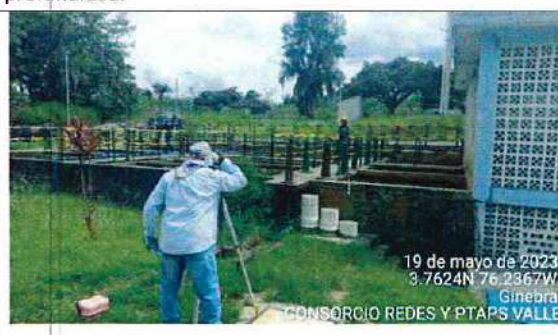
Fotografía 32. Se verifican niveles de las estructuras existentes, para confirmación de cotas que definirán el nivel del tanque proyectado a construir.
