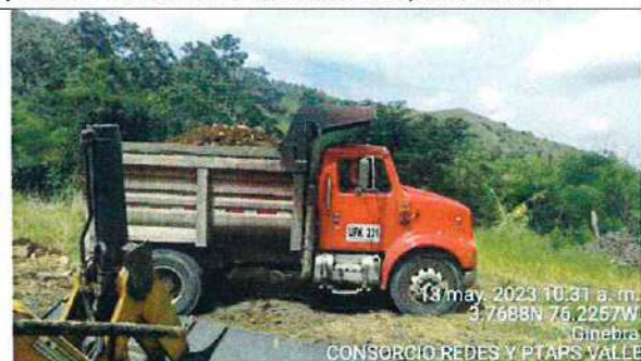
Fotografía 21. Cargue de material seleccionado desde el punto de acopio temporal para reutilizar en los rellenos.
