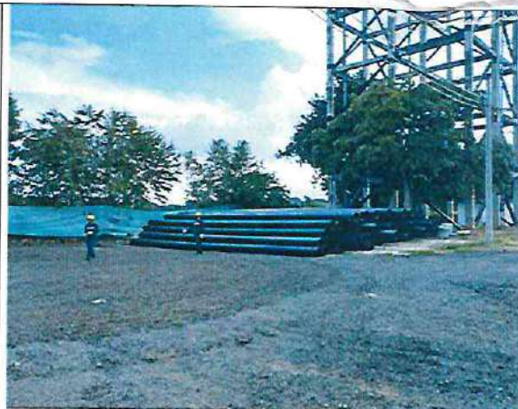
Fotografía 48. Acopio de tubería PEAD de 14" en PTAP Guacarí.
