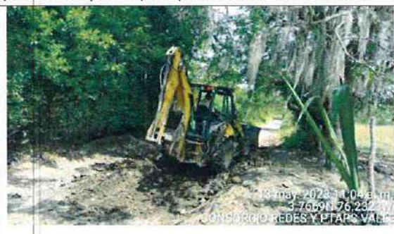
Fotografía 22. Se realizan rellenos con material seleccionado del sitio donde se habían iniciado las excavaciones cerca de la abscisa 0+400 (Acopio Temporal Bodega 2).
