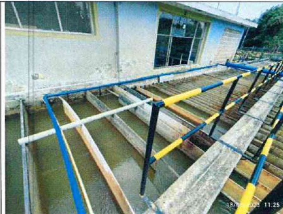
Fotografía 42. Revisión de floculadores.
