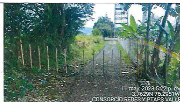
Fotografía 15. Se construye broche en PTAP de Guacarí por solicitud de la plata de Guacarí, esto con el fin de asegurar la tubería resguardada..
