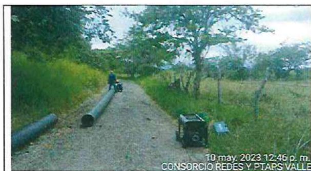
Fotografía 11. La tubería que se encontraba soldada y lista para su instalación ha sido necesario realizar un corte sobre las uniones para poder ser transportada hasta la bodega.
