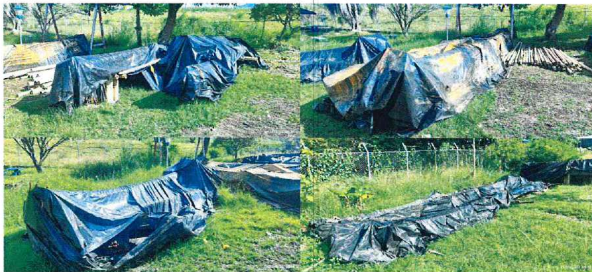
Ilustración 22 Cubrimiento y aislamiento de acero de refuerzo
