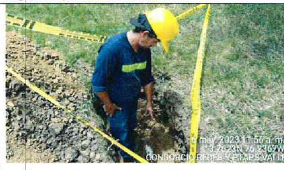
Fotografía 8. Continúa los apliques para identificar la tubería de 12" que sale de la casa de operaciones de la planta y se dirige al tanque de contacto de cloro.
