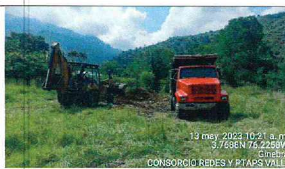
Fotografía 20. Cargue de material seleccionado desde el punto de acopio temporal para reutilizar en los rellenos.
