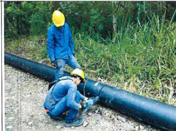
Fotografía 46. Corte de los 7 tubos PEAD de 14"x12ml termofundidos.
