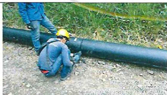
Fotografía 12. Sobre las uniones se ha visto la necesidad de realizar corte con serrucho eléctrico para poder transportar a su sitio de acopio.
