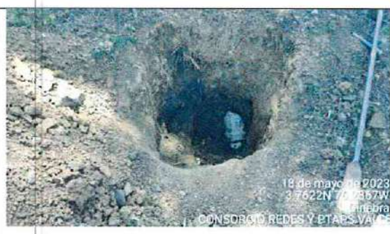
Fotografía 30. Se inicia con el apique para identificación de tubería de salida de PTAP Ginebra para verificación de profundidad.
