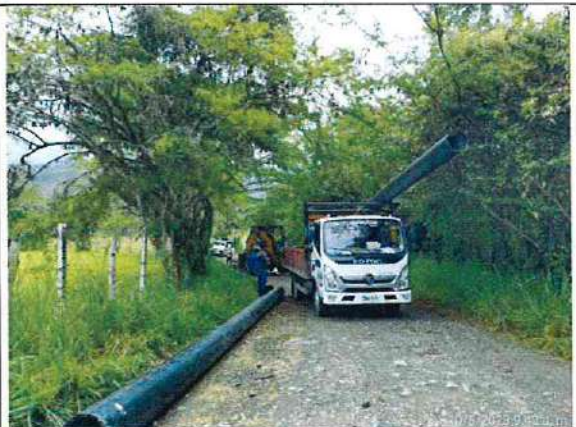
Fotografía 45. Traslado de tubería PEAD 14" suelta en la vía de tramo 3 hacia sitio de acopio en Hacienda La Esmeralda
