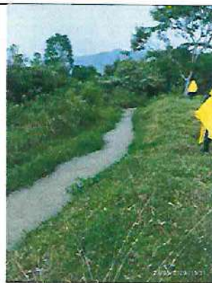
Fotografía 50. Recorrido conducción de agua de bocatoma de Puente Rojo a PTAP Ginebra (1)
