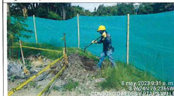
Fotografía 9. Continúa los apliques para identificar la tubería de 12" que sale de la casa de operaciones de la planta y se dirige al tanque de contacto de cloro.
