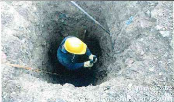
Fotografía 43. Apiques para localización de tubería de 8" que sale del tanque de contacto de cloro.
