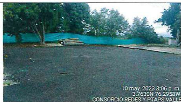
Fotografía 13. Se ha realizado visita al área suministrada por Acuavalle para realizar el suministro de la tubería.
