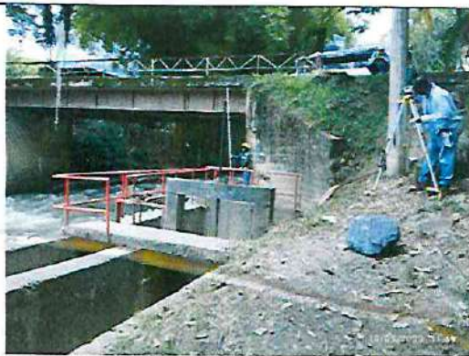
Fotografía 49. Toma de cotas de bocatoma de Puente Rojo.
