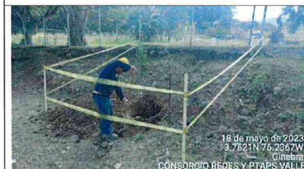
Fotografía 31. Continúa con el apique para identificación de tubería de salida de PTAP ginebra para verificación de profundidad.
