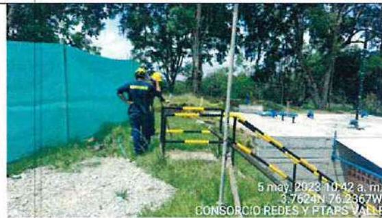
Fotografía 6. Continúa los apliques para identificar la tubería de 12" que sale de la casa de operaciones de la planta y se dirige al tanque de contacto de cloro.
