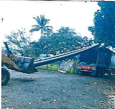
Fotografía 47. Descargue de tubería PEAD de 14" en sitio de acopio PTAP Guacarí.
