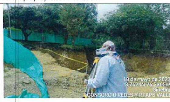
Fotografía 34. Se verifican niveles de las estructuras existentes, para confirmación de cotas que definirán el nivel del tanque proyectado a construir.
