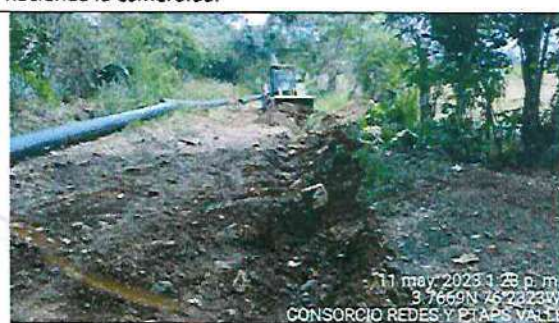
Fotografía 16. Se realizan rellenos con material seleccionado del sitio donde se habían iniciado las excavaciones cerca de la abscisa 0+400.
