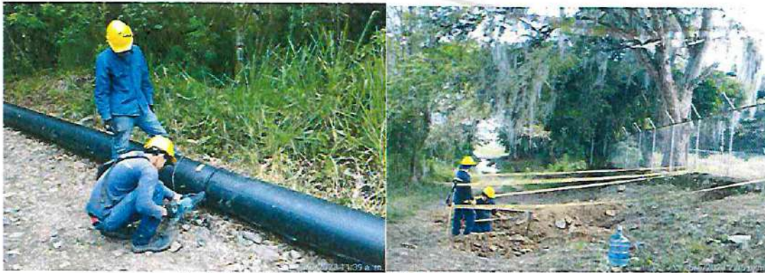
Ilustración 14 Adecuado uso de EPP y Señalización
