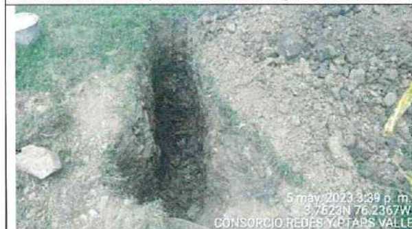
Fotografía 7. Continúa los apliques para identificar la tubería de 12" que sale de la casa de operaciones de la planta y se dirige al tanque de contacto de cloro.
