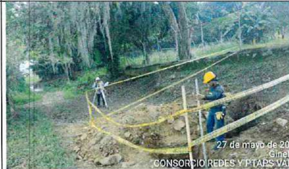
Fotografía 44. Toma de cota de tubería de 8" que sale del tanque de contacto de cloro.
