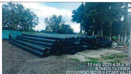
Fotografía 18. Se realiza descargue de tubería 3 mulas en planta de Guacarí en el sitio autorizado por Acuavalle.
