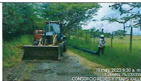
Fotografía 14. Se realiza retiro de la tubería que estaba extendida tubería que estaba sobre el camino a partir de abscisa 0+400, esa tubería se traslada nuevamente a la hacienda la esmeralda.
