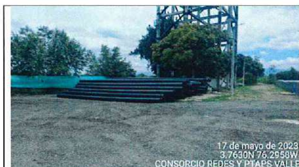
Fotografía 29. Descargue de tubería en lote de planta Guacarí.
