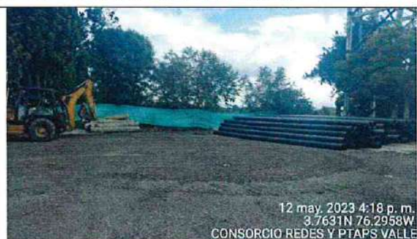
Fotografía 19. Se realiza descargue de tubería 3 mulas en planta de Guacarí en el sitio autorizado por Acuavalle.
