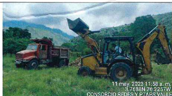
Fotografía 17. Se realizan rellenos con material seleccionado del sitio donde se habían iniciado las excavaciones cerca de la abscisa 0+400 (Acopio Temporal Bodega 2).
