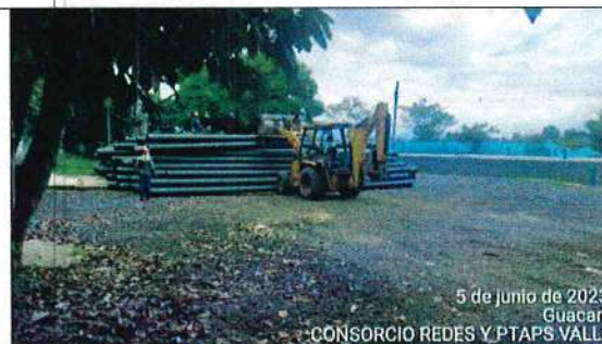
Fotografía 8. Se descarga y acomoda la tubería donde él se asignó el espacio para su acopio.
