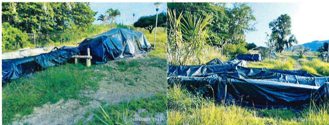
Ilustración 24 Cubrimiento y aislamiento de acero de refuerzo
