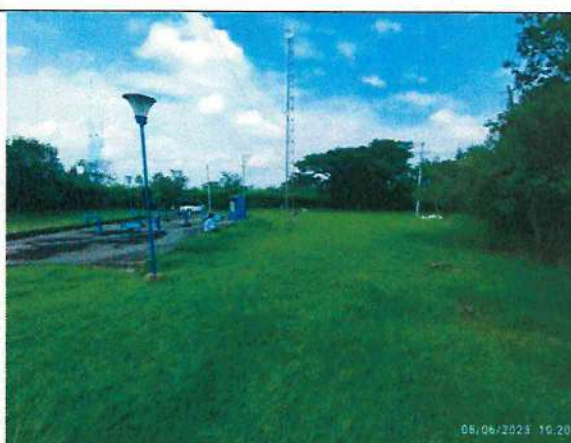
Fotografía 52. Área 2 en predio de Tanques existentes Ginebra
