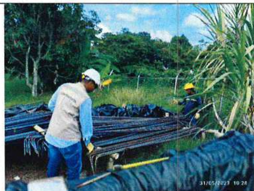
Fotografía 5. Continúa realizando el inventario del acero en obra, verificación de remisiones a cada burro se la asigno un número para mejor control y localización, se verifican existencias de acuerdo a remisiones.
