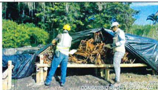
Fotografía 6. Continúa la actividad de inventario del acero que está en obra de acuerdo a remisiones entregadas por proveedor.
