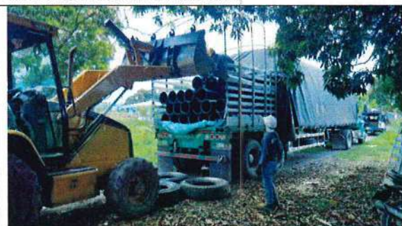
Fotografía 7. Se realiza descargue de tubería en la planta Guacarí, las mulas son procedentes de Extrucol, Bucaramanga.
