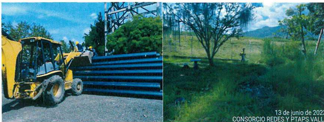
Ilustración 19 Descargue de tubería - Rocería
