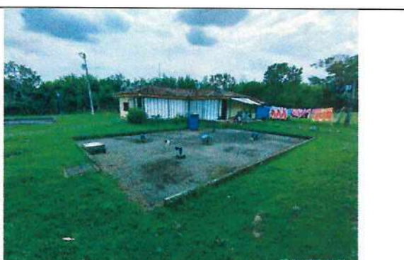
Fotografía 54. Tanque existente N°2
