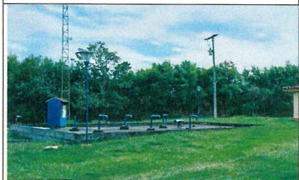
Fotografía 53. Tanque existente N°1
