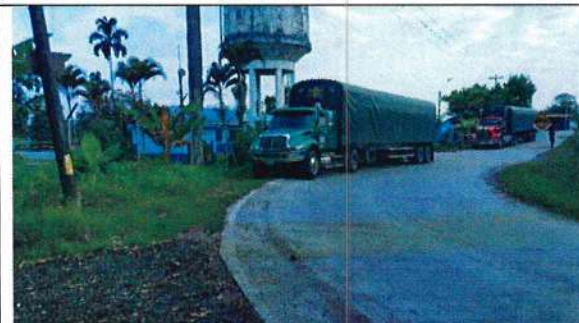
Fotografía 9. Se realiza descargue de tubería en la planta Guacarí, las mulas son procedentes de Extrucol, Bucaramanga.
