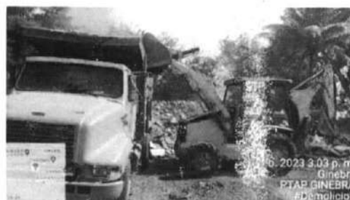
FOTOGRAFÍA No.2: Demolición de la caseta del operador Ptap Ginebra, se acopia el material para posteriormente ser enviada a un botadero autorizado,
