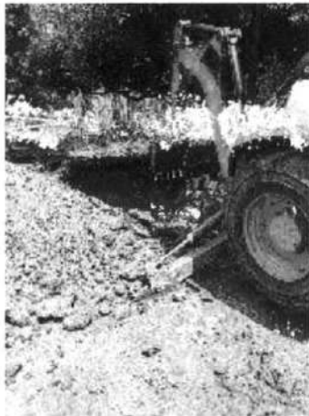
Foto 19. Inicio excavación tanque de agua y retiro de material sobrante de la excavación
