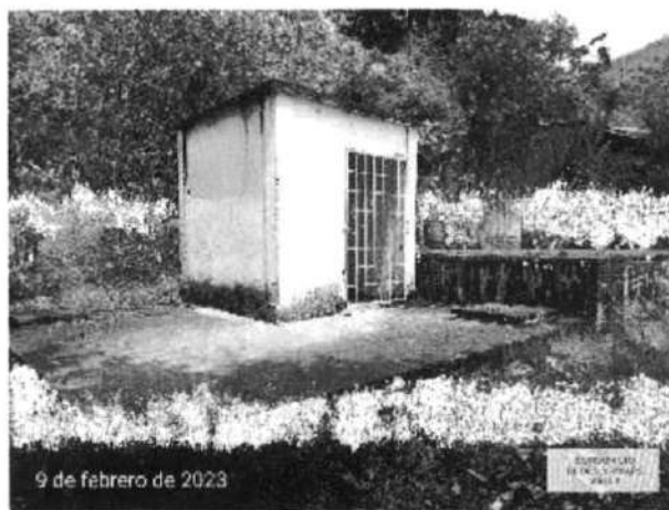
Foto 2. Tanque de agua potable Puente Rojo
