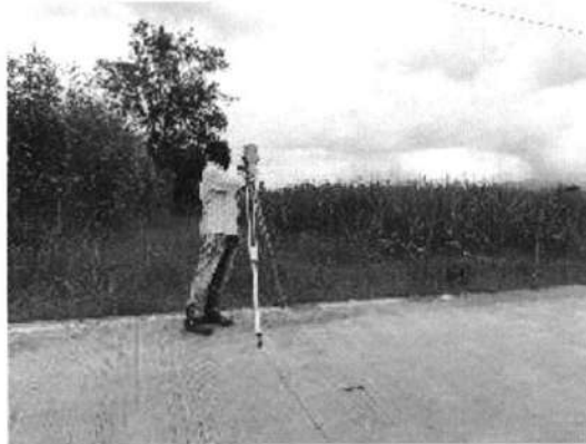
Foto 13. Topógrafo del contratista realizando actividades de localización de la tubería de conducción en la vereda Guabitas
