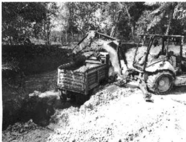
Foto 20. Excavación zona tanque de agua planta Ginebra y retiro de material sobrante
