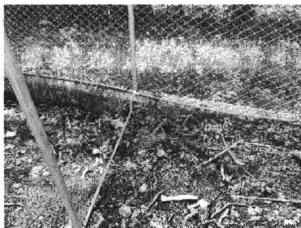
Foto 18. Reubicación de luminarias y trazado red eléctrica
