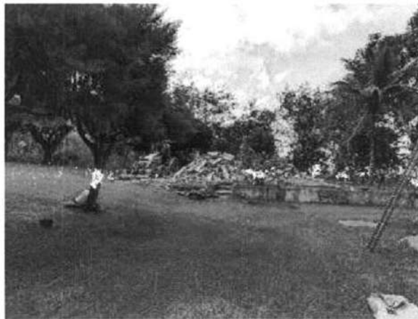
Foto 17. Demolicón caseta operadores
