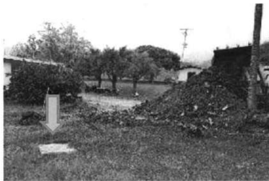
Foto 18. Caja de inspección aguas residuales a reubicar
