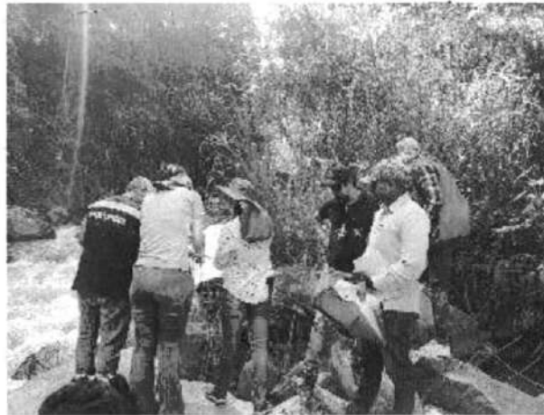
Foto 15. Sitio de ubicación de la bocatoma – Sector Puente Piedra
