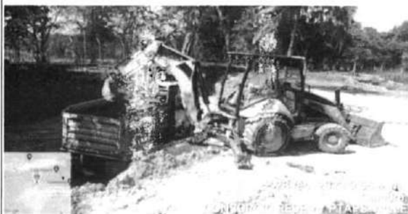
FOTOGRAFÍA No.5: Carga y Retiro de material sobrante a lugar autorizado.
