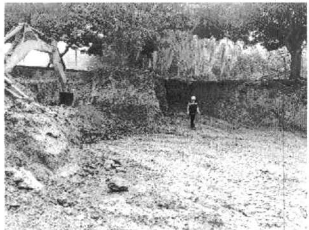
Foto 20. Excavación zona tanque de agua planta Ginebra y retiro de material sobrante
