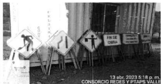
FOTOGRAFÍA No.6: Señalización para PMT, instalación tubería conducción hacia Guacarí
