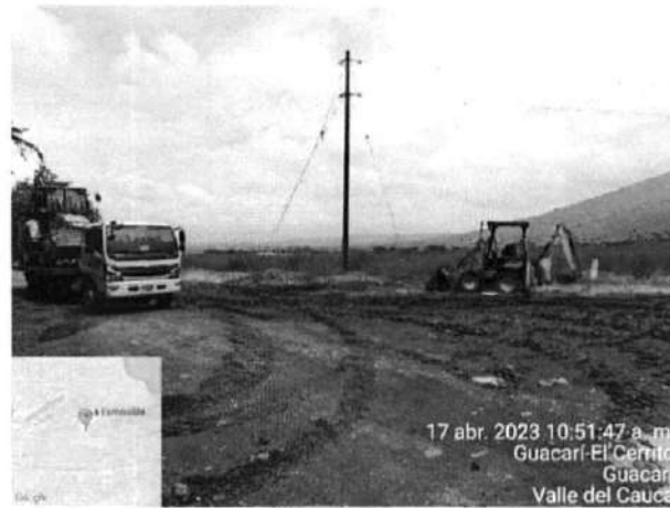
Foto N° 18: Llegan las retroexcavadoras para iniciar el trabajo de excavación e instalación de la tubería PEAD
