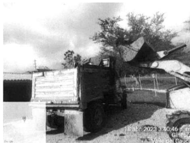
Foto N° 20: Cargue de tierra
