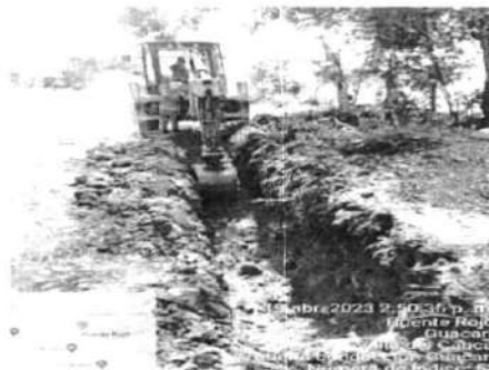
FOTOGRAFÍA No.8: Instalacion tuberia conduccion 14" hacia Guacari
