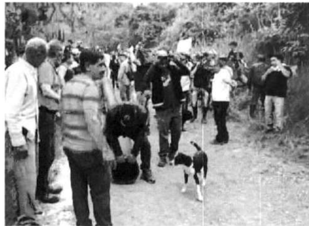
Foto N° 4: Abscisa K0+400 donde se inició a instalar la tubería. Se observa a la comunidad retirando la tubería
