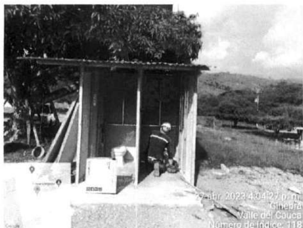
Foto N° 23: Construcción baños personal de obra
