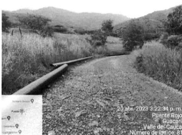
Foto N° 5: Tubería ubicada en el eje derecho de la vía
