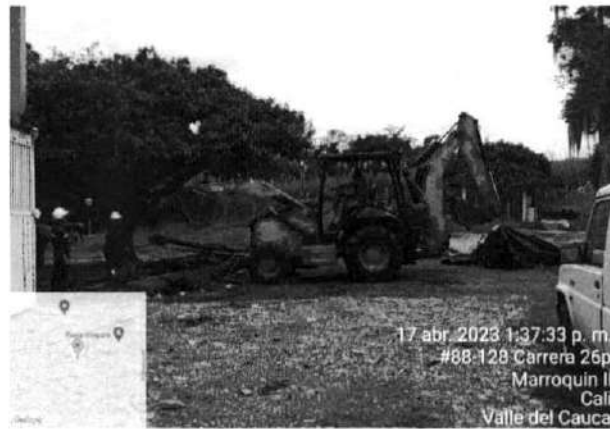
Foto N° 17: Retroexcavadora reubicando el acero de refuerzo
