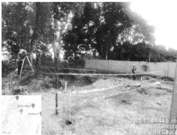
Foto N° 14: Comisión de topografía, realizando nivelación del tanque
