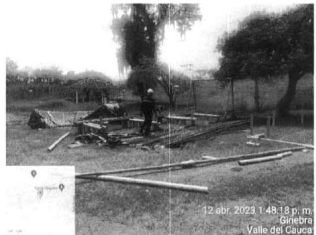
Foto N° 15: Personal reubicando el acero de refuerzo
