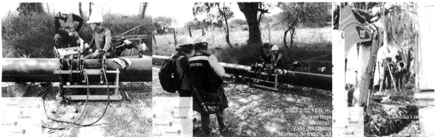
Foto N° 21: Proceso para inicio de instalación de la tubería PEAD de diámetro 14", en el tramo 3, en la abscisa K0+400
