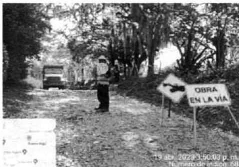
FOTOGRAFÍA No.7: Instalacion tuberia conduccion 14" hacia Guacari
