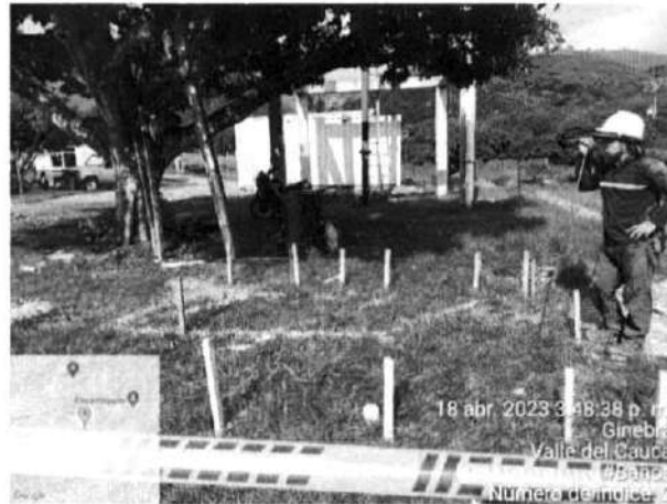
Foto N° 20: Localización, replanteo y excavación tubería baños trabajadores
