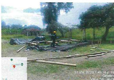
FOTOGRAFÍA No.5. Acero de refuerzo tanque almacenamiento PTAP Ginebra
