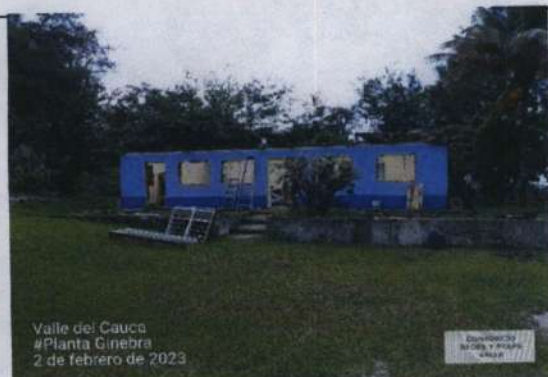
FOTOGRAFÍA No.1: EN LA PTAP GINEBRA SE REALIZÓ LA DEMOLICION DE LA CASETA DE OPERADORES EXISTENTES, DANDO PASO EN ESA AREA LA EJECUCION DEL NUEVO TANQUE DE ALMACENAMIENTO DE ACUERDO A PLANOS Y ESPECIFICACIONES.
