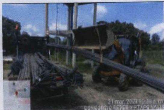
FOTOGRAFIA No.4: ACERO EN OBRA PARA LA CONSTRUCCION DEL TANQUE DE ALMACENAMIENTO DE AGUA TRATADA, EN CONCRETO REFORZADO PTAP GINEBRA, DE ACUERDO A PLANOS Y ESPECIFICACIONES.
