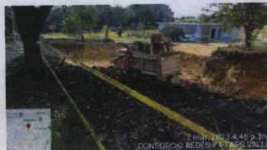
FOTOGRAFÍA No.2: ACTIVIDADES DE EXCAVACION A MÁQUINA, PARA LA CONSTRUCCION DEL NUEVO TANQUE DE ALMACENAMIENTO DE AGUA TRATADA PTAP GINEBRA DE ACUERDO A PLANOS Y ESPECIFICACIONES.
