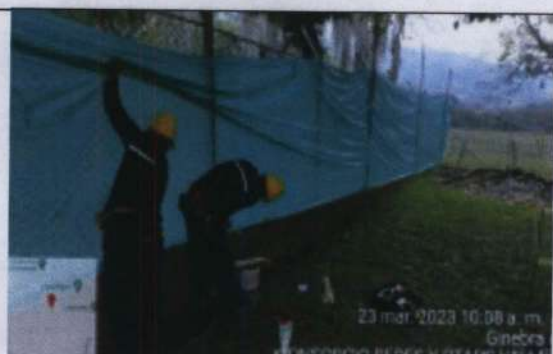
FOTOGRAFÍA No.8: CERRAMIENTO EN TELA TEJIDA VERDE CUMPLIMIENTO MANEJO SALUD OCUPACIONAL, CALIDAD, SEGURIDAD Y AMBIENTALDE ACUERDO A PLANOS Y ESPECIFICACIONES.
