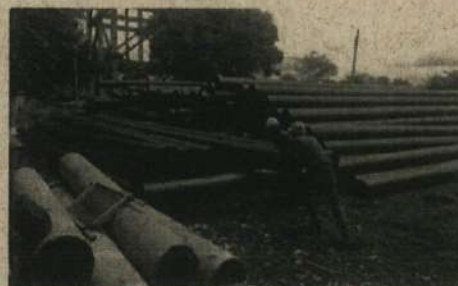
FOTOGRAFIA No.4: SUMINISTRO DE TUBERIA PARA LINEAS DE ADUCCION Y CONDUCCION DE ACUERDO A PLANOS Y ESPECIFICACIONES. SUMINISTRO TUB PEAD DN 350MM Y 450MM PN10
