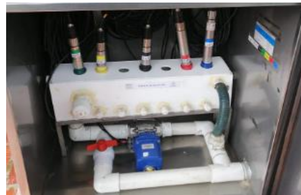
b) Montaje actual Estación Ancón Sur
