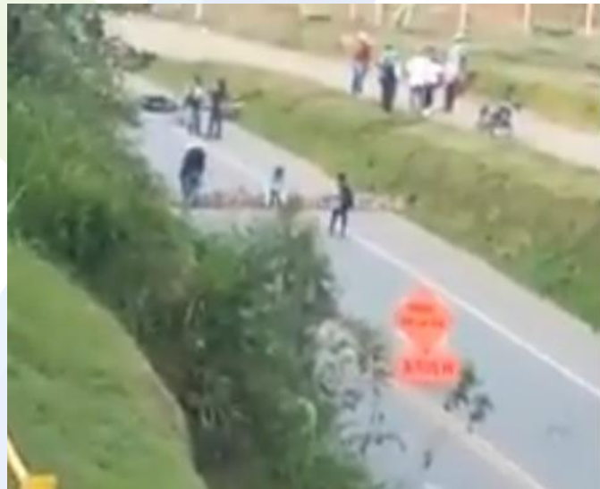
Fotografía 3: Derrumbes en las vías al norte del Cauca
