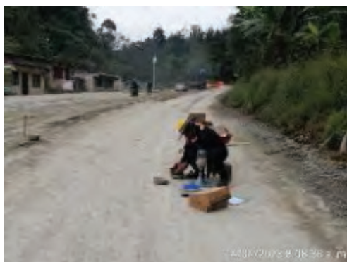
Toma de Densidades a la subbase PR1+830-MD
