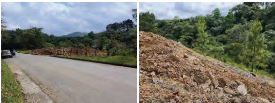
Fotografía 1 y 2 – Acopio temporal PR14+500
