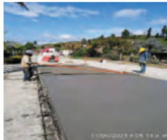
PR1+605-MD- Instalación de pavimento hidráulico MR42
