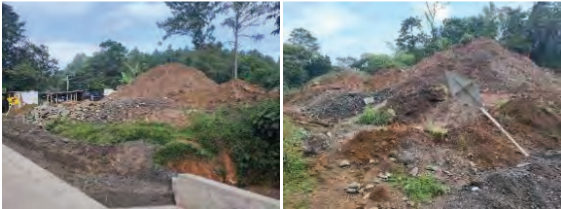
Fotografía 3 y 4 – Acopio temporal PR0+400
