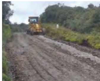
Mantenimiento PNN Purace PR59+000
