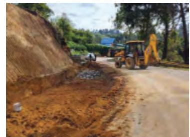
PR 4+360 al PR4+420-MD Cajeo a nivel de subrasante
