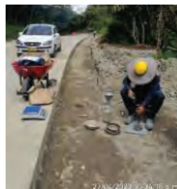
Toma de Densidades a la subbase cunetas PR0+442
