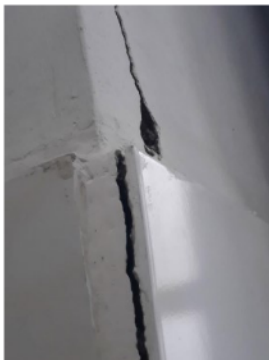
Agrietamiento en placa de entrepiso
