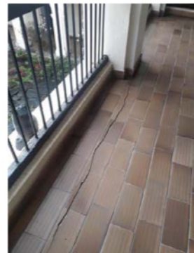
Agrietamiento en placa de entrepiso
